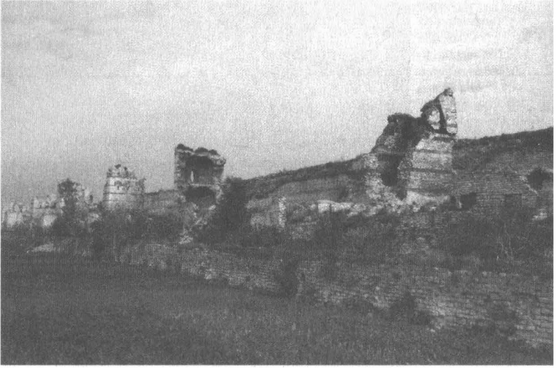
3. II. Theodosios tarafından 413'te inşaatı tamamlanan kara surlarının batıdan görünüşü.
