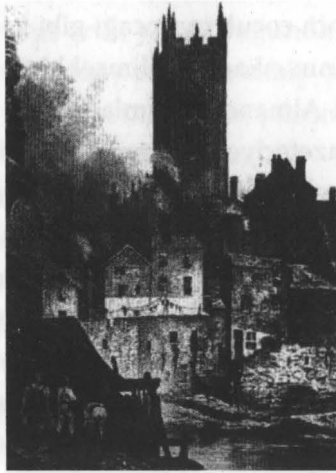
Manchester'da işçiler ve ailelerinin doluştuğu eski evler.
