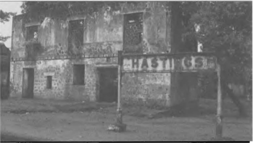
Yaratıcı olmayan yıkım: Sierra Leone'de Bo yolu üzerindeki terk edilmiş Hasting demiryolu istasyonu.
