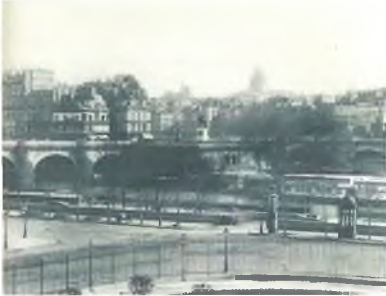
[Resim b.] Charles Soulier, Louvre Revaklarından Çekilmiş Paris Panoraması , yak. 1865. Bibliothèque nationale de France, Paris
