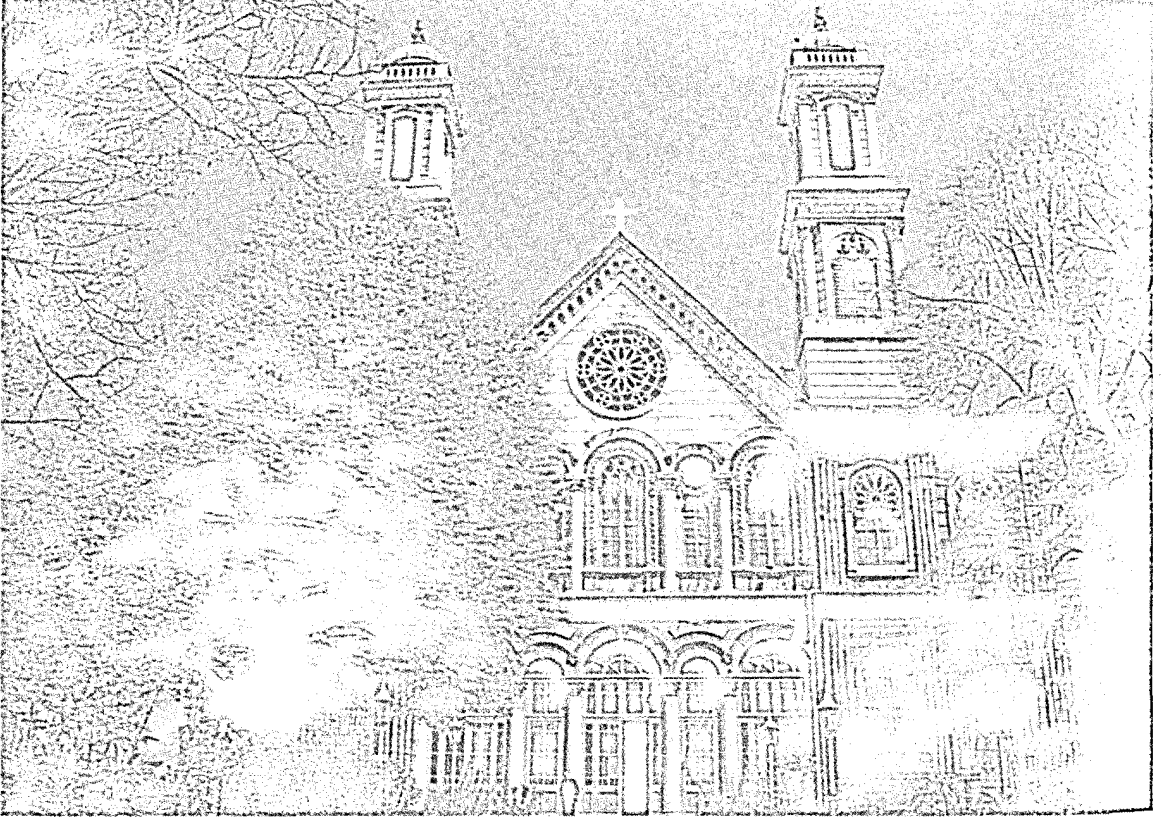
İlk projesini mimar Potessaro'nun yaptığı, daha sonra mimar Vasilaki İoannidi tarafından yürütülen ve 13 yıl süren inşaatın sonra 14 Eylül 1880'de ibadete açılan Taksim'de Meşelik Sokağı'nda bulunan Aya Triada Kilisesi.
