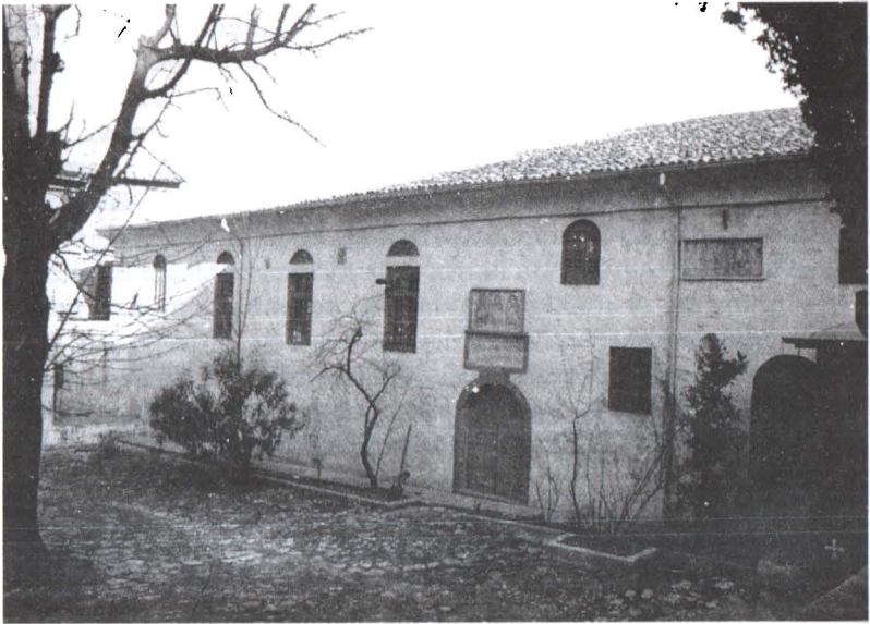
Fener Hagios Georgios Poteras Kilisesi, güney cephe.
