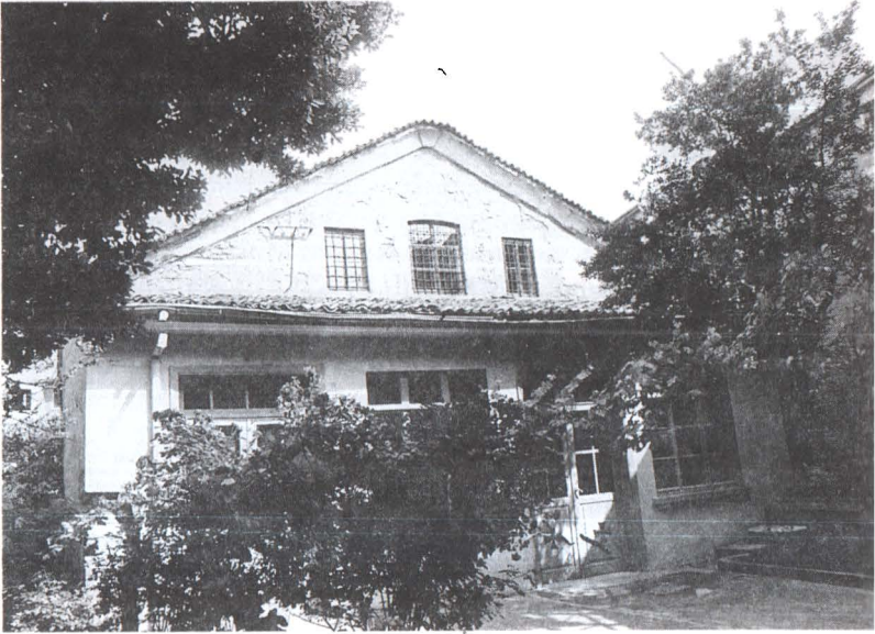
Salmatomruk Panagia Kilisesi, batı cephe.
