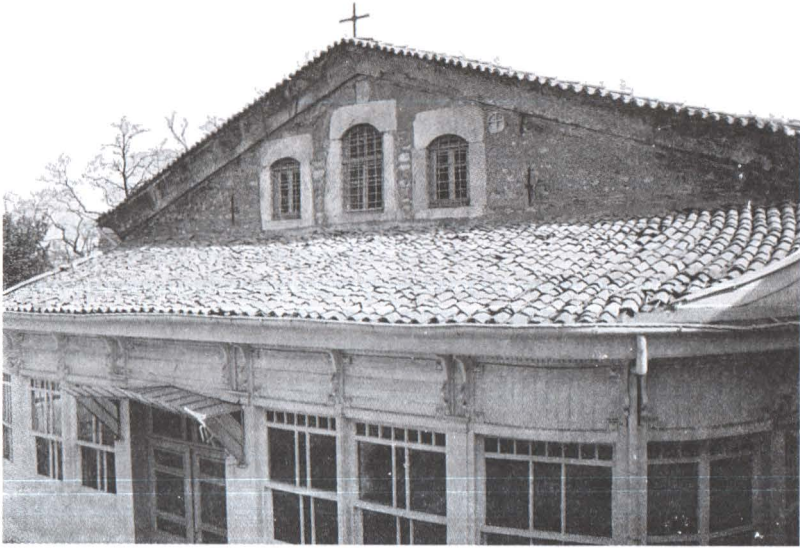
Topkapı Hagios Nikolaos Kilisesi, batı cephe.
