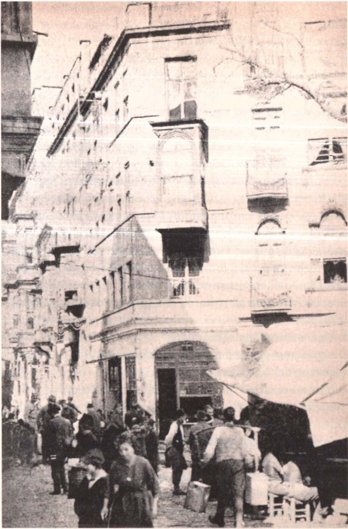
Demetra Vaka'nın küçük bir kızken önünde oturup hayaller kurduğu penceresiyle Yüksekkaldırım'daki cumbalı ev
