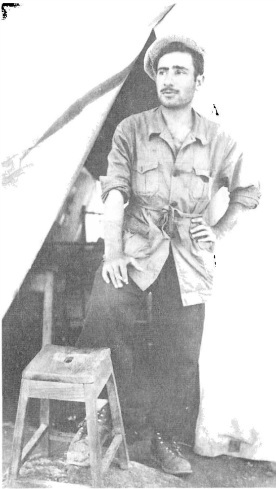
Aydın Boysan, Podima inşaatında şantiye çadırının önünde.
