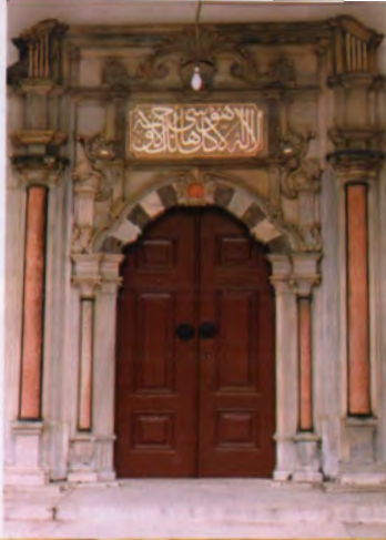
Mihrişah Valide Sultan Türbesi (Dış görünüm)
