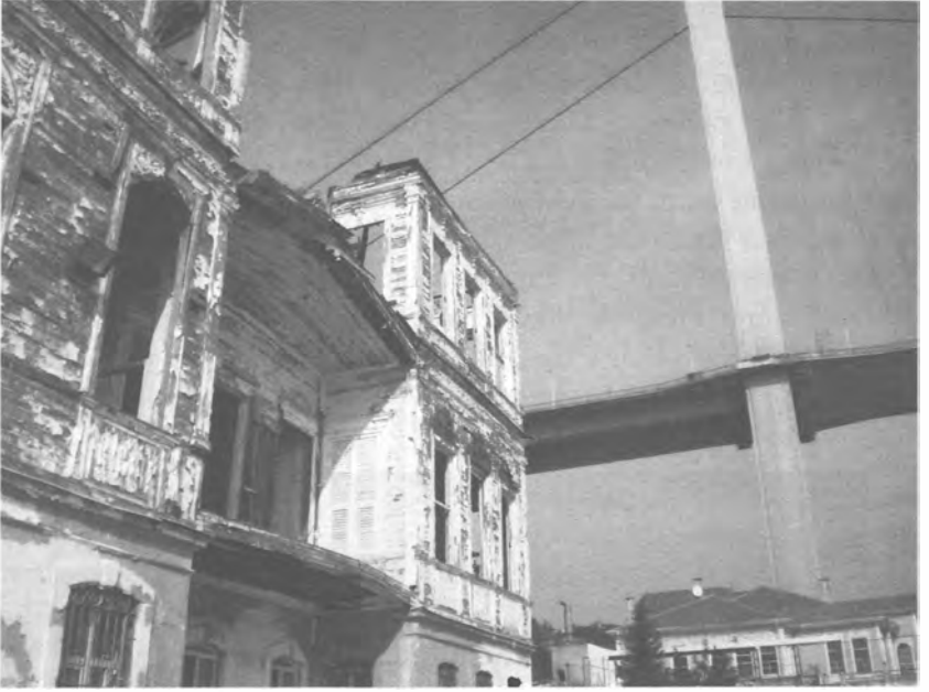
Önde Gazi Osman Paşa'nın yanık yalısı, geride Boğaziçi Köprüsü
