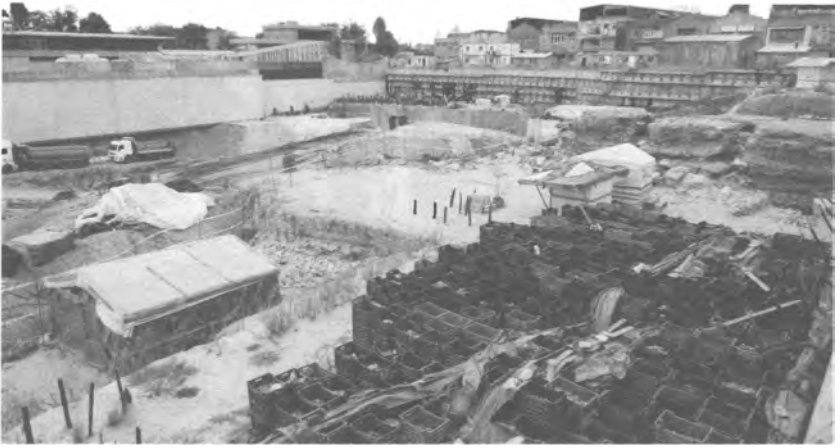
Marmaray Yenikapı istasyonu inşası ve hemen yanındaki Teodosius Limanı kazıları
