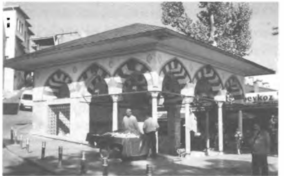
İshak Paşa'nın 1746'da yaptırdığı On Parmak Çeşmesi
