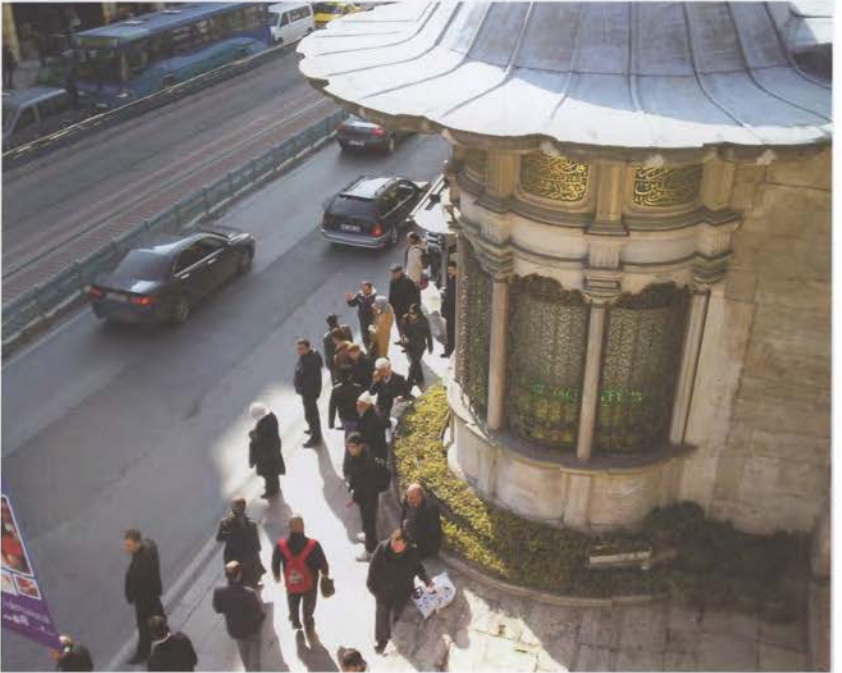
Laleli Külliyesi'ne ait Sultan III. Mustafa ve Sultan III. Selim Türbesi
