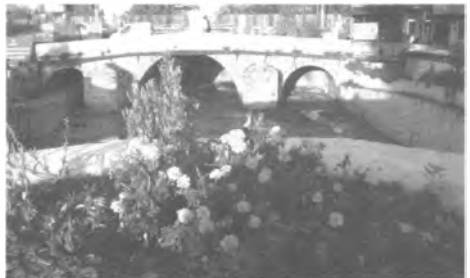
İstanbul şehri içindeki en eski Osmanlı köprüsü: Bostancı Köprüsü
