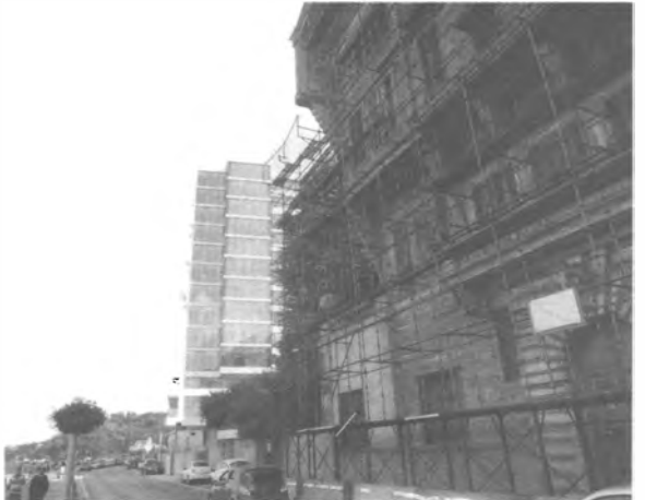
Önde hâlen onarımda olan D'Aronco'nun İtalyan Konsoloslugu binası, geride Tarabya Otelı
