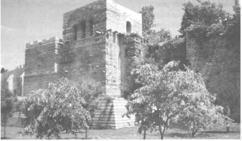
Kara Surlarının Ayvansaray mevkiisindeki en ünlü Roma yapılarından Anemas Zindanı
