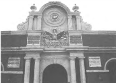
19. yüzyılın anıtsal sanayi tesisi Feshane'nin ön cephesi
