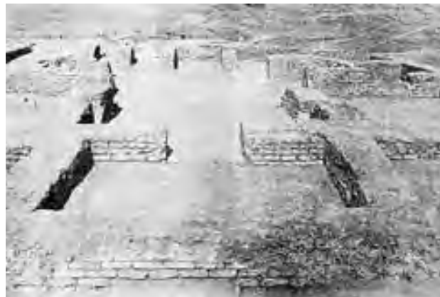
Tahmin edilen kütüphane binasının temel duvarları.
