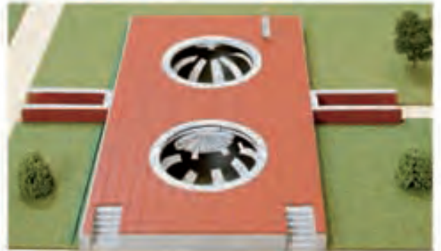
Kapāla , çapı 3,45 metre ( 11\frac{1}{3} ayak) olan iki yarım küreden oluşmaktadır. Bir kürenin kenarı ufuk dairesini, diğer kürenin kenarı ise en uzun günü göstermeye mahsus daireyi temsil etmektedir. İlk kürenin iç yüzeyi meridyen çizgilerini, diğerinin yüzeyi ise yükselişleri ( tulū° ) bulundurmaktadır. Bu araç Delhi Rasathanesi'nde bulunmamaktadır.
