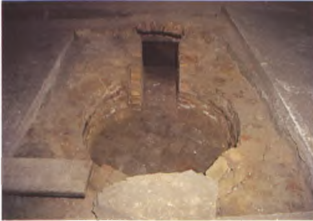
3 Dolmabahçe Sarayı Muayede Salonu bodrumunda bulunan ve salonun ısıtma sisteminde kullanılan ocaklara bir örnek.
