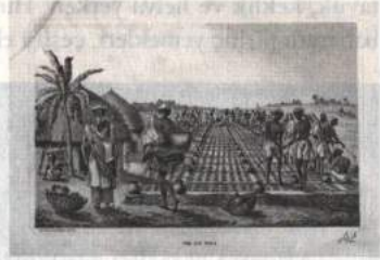
Buz üretim yeri, Allahabad, 1828. Yüzlerce küçük çukura doldurulan suyun üzerinde gece soğuşunda buz tabakası oluşur, işçiler bunları çıkararak buzluklara götürürlerdi.
