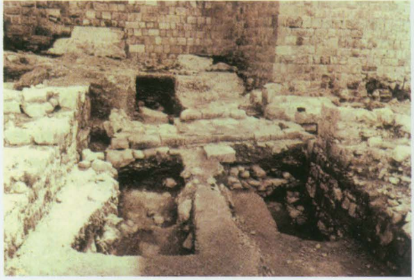
Valilik Binası 'na açılan kapının kazı esnasındaki görüntüsü.
