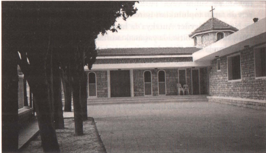
Vakıflı Surp Asdvadzadzin Ermeni Kilisesi, 1997'deki restorasyondan sonra.
