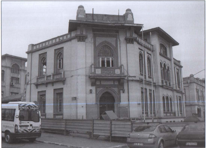
Fatih itfaiye binası
