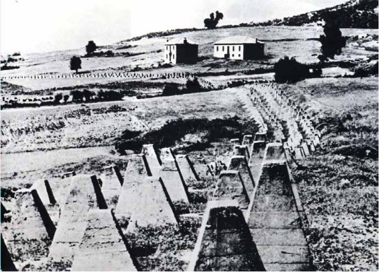
Metaxas Hattı, Almanlara karşı Yunanistan'ın Bulgar sınırında oluşturduğu tankların geçişini engelleyen beton barikatlardı.
