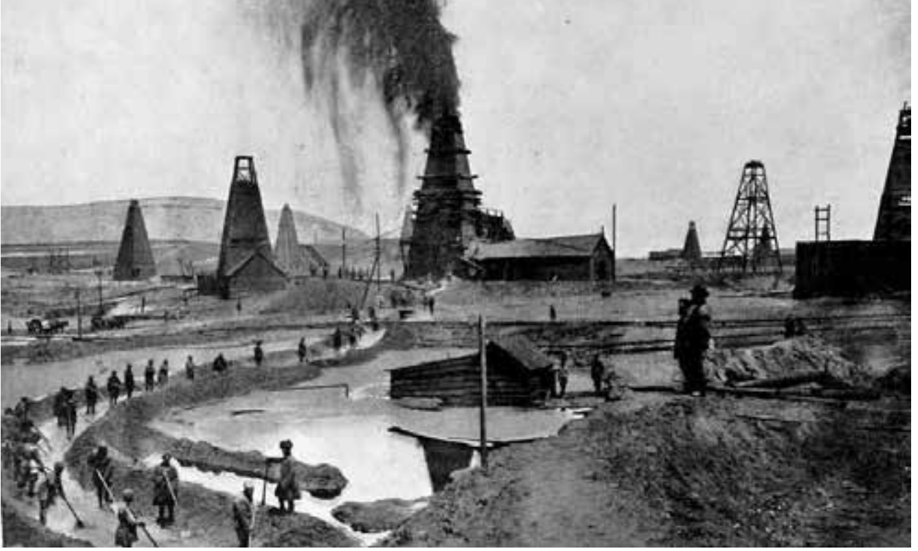
Bakü petrol tesislerinde petrol çıkarma çalışmaları
