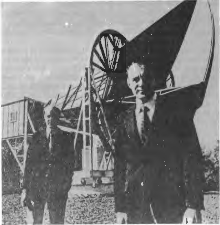
Holmdel Radyo Teleskobu: Arno Penzias (sağda) ve Robert W. Wilson (solda), 1964-65'de 3 K'lık kozmik mikrodalga arkaalan ışımasını keşiflerinde kullandıkları 610 cm'lik boynuz antenle görülmüyorlar. Bu teleskop, Bell Telefon Laboratuvarı'nın New Jersey'deki Holmdel bölgesindedir. (Bell Laboratuarları'nın fotoğrafı)
