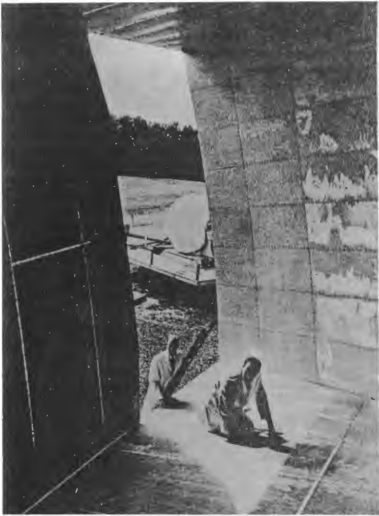
Holmdel Radyo Teleskobun İçinde: Penzias burada Holmdel'deki 610 cm'lik boynuz antenin ek yerlerini bağlarken, Wilson ise onu izlerken görülüyor. Bu, antenin yapısından kaynaklandığı sanılan ve 1964-65'de gözlenen 3 K'lık mikrodalga gürültüsünü açıklayabilecek olası elektrik gürültü kaynağını yok etme çabasının bir parçasıydı. Bütün bu çabalar gözlenen mikrodalga gürültüsünün şiddetini sadece biraz azaltmayı başardı ve mikrodalga ışıınının aslında astronomik kökenli olduğu sonucuna varmak kaçınılmaz oldu. (Bell Telefon Laboratuvarı fotoğrafı)
