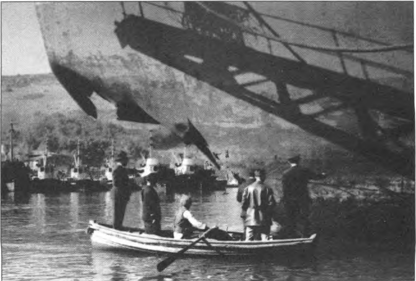
Naboland'ın hasarı olanca çıplaklığıyla gözler önündeydi.
