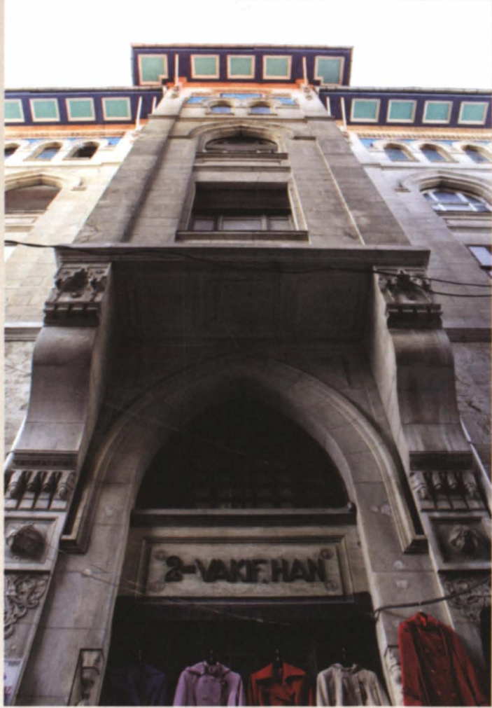
2. Vakıf Han'ın cephe görünümü
