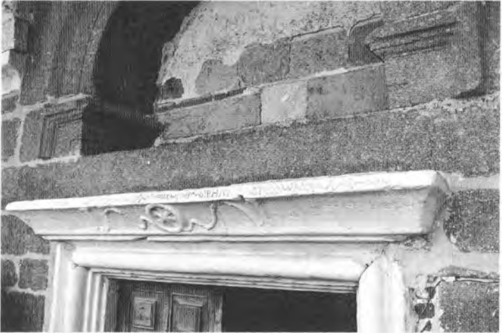
Resim 1.9: Assos Caminin kapı kasası üzerindeki kitabe.
