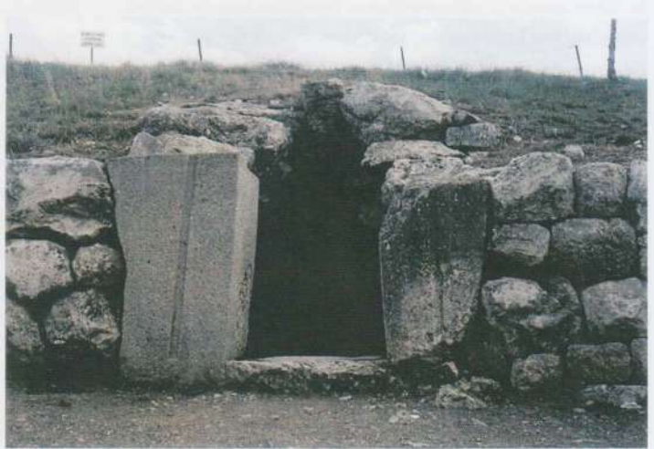
Arka kapı. Olası bir kuşatma esnasında levazım toplamak veya düşman kuvvetlerine karşı baskın taarruzlarında bulunmak için şehir muhafızlarına giriş ve çıkış olanağı sağlayan gizli tüneller, Tunç Çağı tahkimatının tipik bir özelliğiydi. Fotoğrafta görünen çıkış kapısı Hattuşaş'ın güney surlarında bulunmaktadır.
