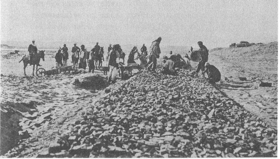
Hicaz demiryolunun inşası
