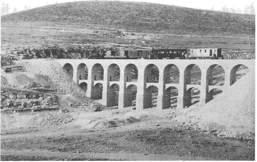
Amnan ve Kasr istasyonları arasında yüksekliği 20 metre her birinin eni 12 metre olan 10 gözlü demiryolu köprüsü
