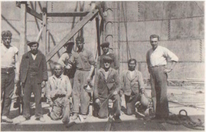
Eduard Bischoff, Paşabahçe Petrol Tankları'nın inşaatında çalışan işçilerle birlikte (sağ başta, ayakta). (1938)
