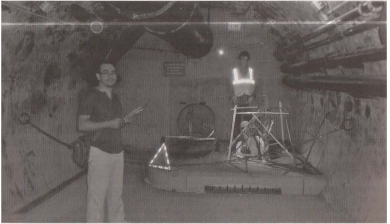
Nasıl çalışması gerektiğini gösteren bir köşe. Dar alanlarda, menhollerde çalışırken tam teçhizatlı olmak ve en az iki kişiyle çalışmak gerekiyor. Aksi takdirde zehirli gazlar baş dönmesi, bayılma ve zehirlenmeye neden olabiliyor.
