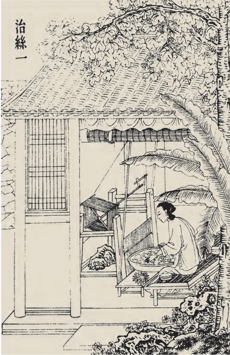
İpek çekme, Tiangong Kaiwu 'da (Doğa Eserlerinin Araştırılması) yer alan bir resimleme.
