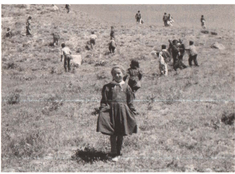
Aynalıhoca köy okulu inşaatı için Murat Nehri yatağından torbalarla kum taşıyor çocuklar.
