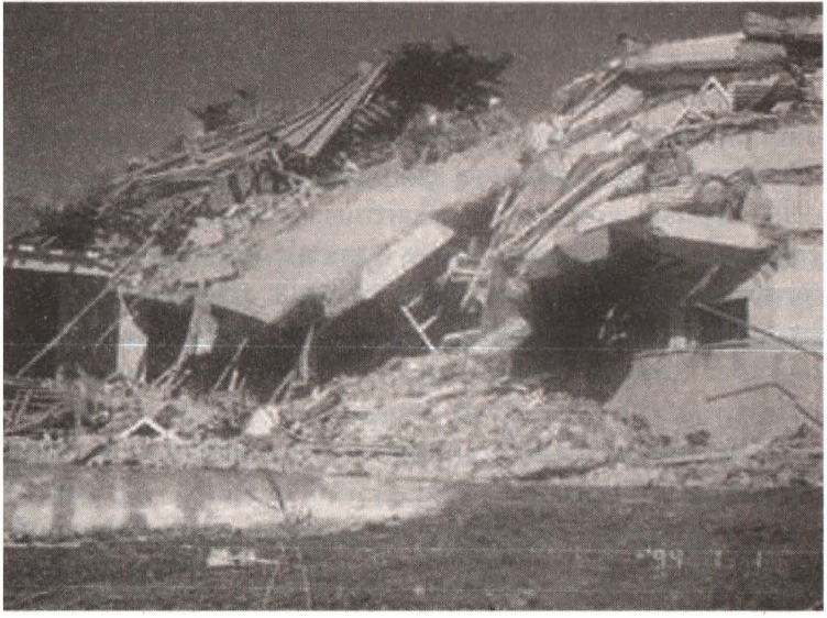
Çeltiksuyu PİO yatakhanesinin deprem sonrası hali.
