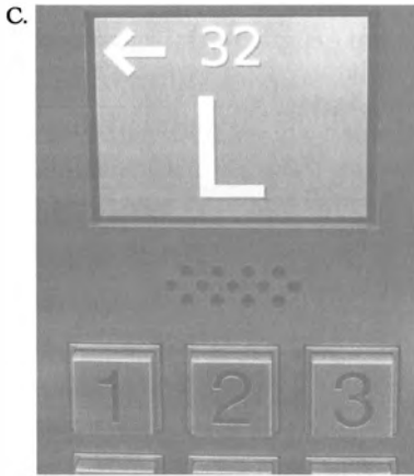
Şekil 4.8. Yön Denetimli Asansörler. Yön denetimli sistemde gidilecek katın bilgisi asansörün dışında duran denetim paneline girilir (A ve B). B'deki panele gidilecek kat girildikten sonra panel, yolcuyu ilgili asansöre yönlendirir; C'de gideceği katı "32" olarak giren kişinin "L" asansörüne (A'da görülen soldan birinci asansöre) yönlendirildiği görülmektedir. Katı, kabin içinde belirlemenin yolu yoktur. Kabin içindeki düğmeler yalnız kapıyı açmak, kapatmak ve alarm zilini çalmak içindir (D). Bu çok daha verimli bir tasarımıdır, ancak daha geleneksel sistemlere alışkın kişilere karışık gelir. (Fotoğraflar yazar tarafından çekilmiştir.)
