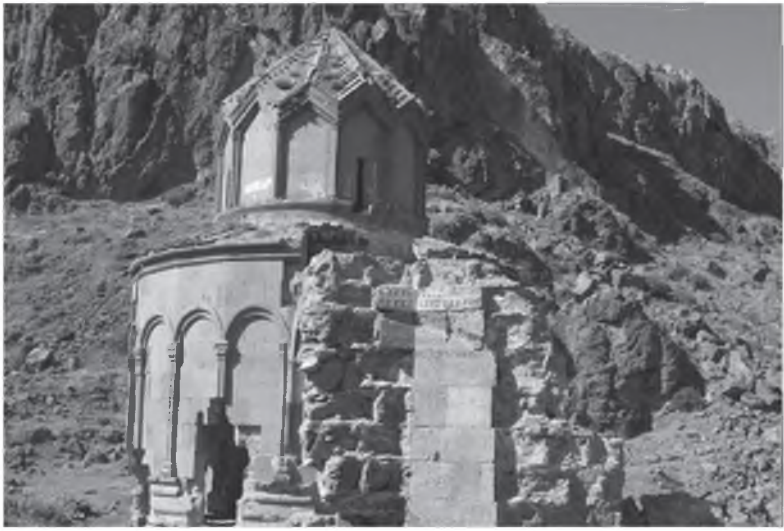
Beş Kilise son hali yıkılıyor
