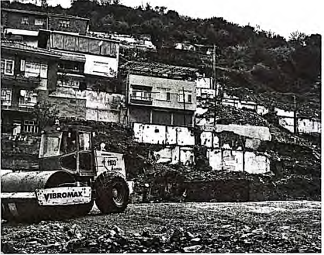
Santral Yokuşu mevkiinde yapılan kentsel dönüşüm (Fotograf Tuncay Bilecen).
