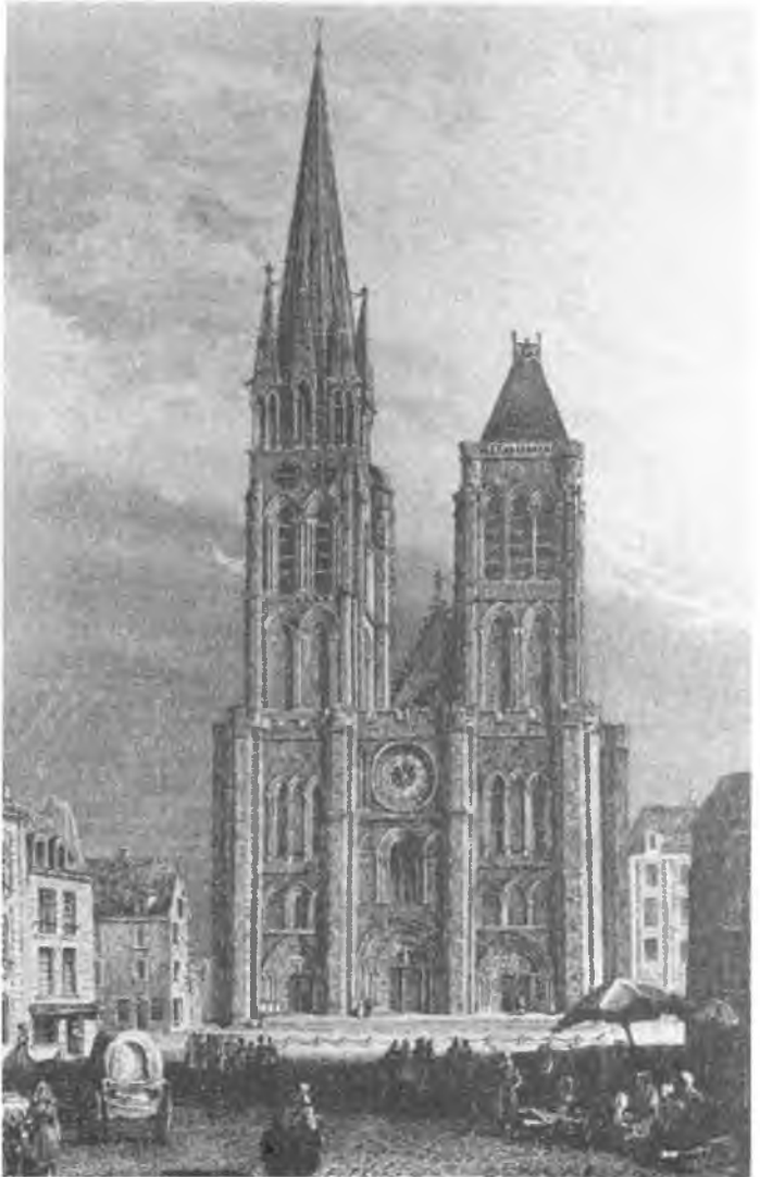
Resim 30: St. Denis, batı cephesi, 1140 yılında vakfedilmiştir. (A. ve E. Rourage'un, 1833-1837 restorasyonundan önce yaptıkları bir gravürden.)
