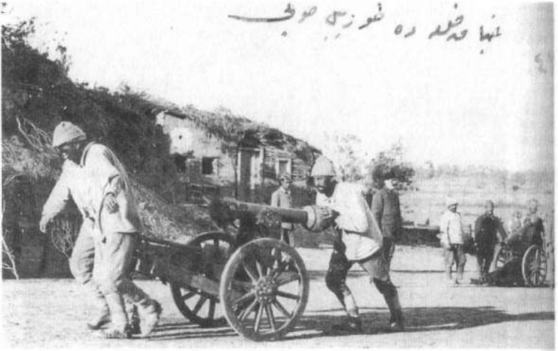
Osmanlı askerleri tekerlekli bir taşıyıcının üzerinde kaideye monteli sıradışı bir hafif topu götürüyor. Namlu ağzındaki hazne, topu ileri itmeye yardımcı olan tahta bir blok gibi görünmektedir.
