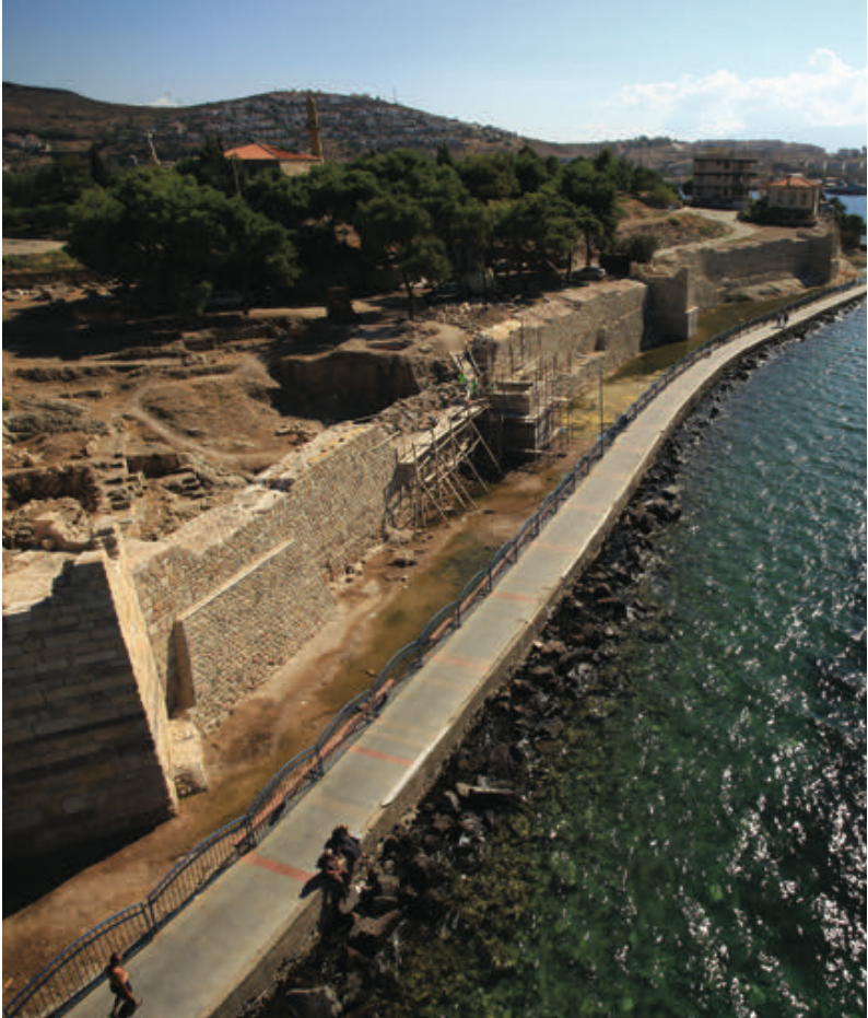
Foça kent duvarlarının [Bizans, Ceneviz ve Osmanlı dönemleri] restorasyonunun son aşamasının havadan bir görünümü.
