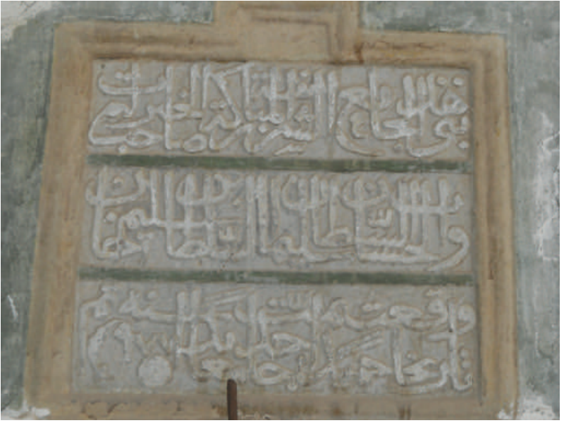
Foça Fatih Camiinin ana giriş kapısının üzerindeki onarım yazıtı.
