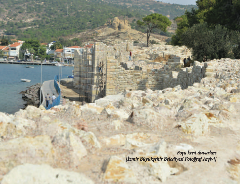
Foça kent duvarları [İzmir Büyükşehir Belediyesi Fotoğraf Arşivi]
