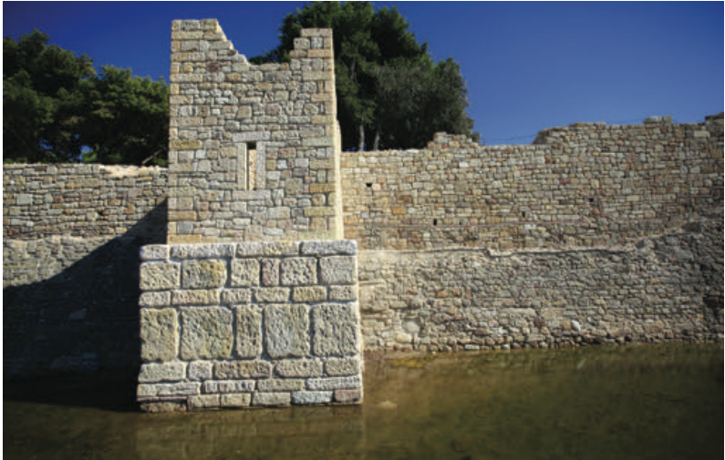
Foça kent duvarlarının restorasyon sonrası bir görünümü. Görülen kule Kanuni Sultan Süleyman'ın oğlu Saruhan Sancak Beyi Sultan Mustafa tarafından 1538 yılında yaptırılmıştır.
