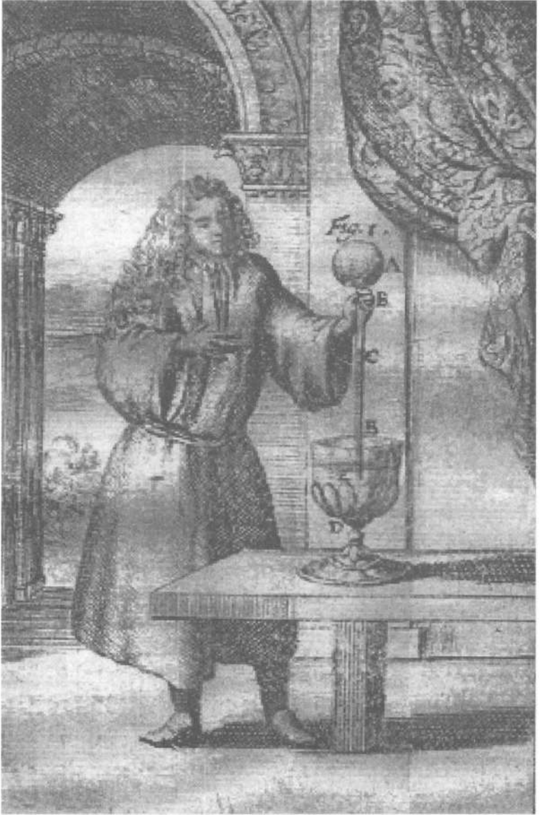
ŞEKİL 91. İtalyan tipi açık hava termoskopu: “İtalyan tipi termometre” de denilen bu tip termometre, üst tarafta içinde hava bulunan kapalı bir balon ile alt tarafta ağzı havaya açık bir kap içindeki su ya da alkole daldırılmış bir borudan ibarettir [Joachim d’Alencé (Dalancé) (1640-707), Traitez des baromètres, thermomètres et notiomètres (Amsterdam, 1695)]. 100
