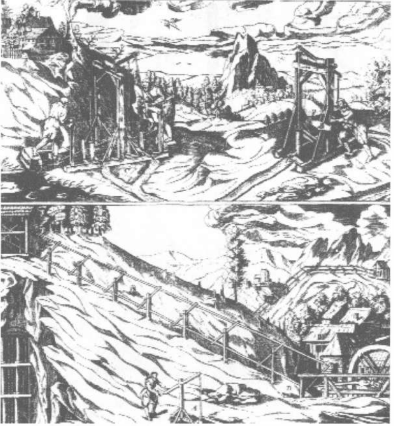
ŞEKİL 115. Maden alanında pompa tesisleri (üstte) ve bir su çarkının enerjisini oldukça uzak mesafedeki iki ayrı maden ocağı pompasına iletmeye kullanılan sııklı kuvvet iletim sanatı (altta) [Georg Engelhardt von Löhneyss, Bericht vom Bergkwerck (Madencilik Üzerine Rapor), Zellerfeld, 1617]. 13,114,115
