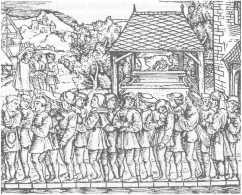
ŞEKİL 127. Jakob Köbel'e (1460-1533) göre "ortalama ayak uzunluğunun belirlenmesi yoluyla bir ölçüm çubuğunun üretilmesi" işlemi (1584): Olasılıkla kilisedeki törenden ilk çıkan on altı adam, sol ayaklarını uç uca yerleştirmekte; toplam uzunluk, on altıya bölünerek ortalama "ayak" uzunluğu saptanmaktadır [J. Köbel, Geometrey. Von künstlichem Feldmessen und absehen (Geometri: Yayıp Saha Ölçüm ve Kestirimi Üzerine), Frankfurt/M., 1608]. 104
