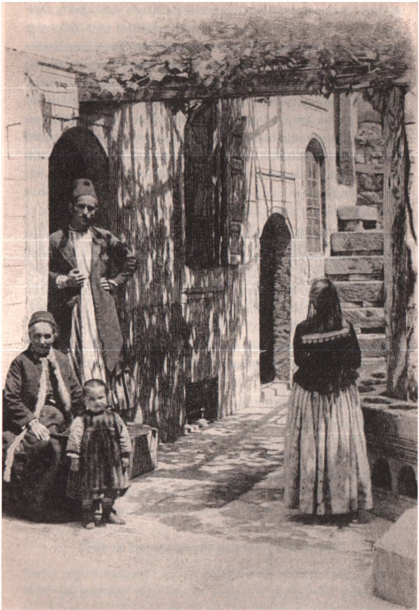
INTÉRIEUR DE MAISON À CÉSARÉE. — D'APRÈS UNE PHOTOGRAPHIE.
