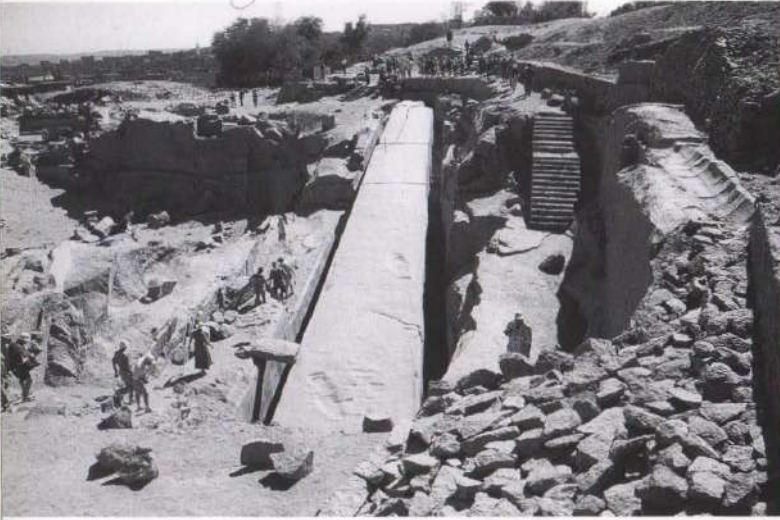
Assuan'daki tamamlanmamış dikilitaş 18. Hanedan'dan kalmış olmalıdır. Ciddi bir doğal kusur bulunmamış olsaydı, bu taş, dikilebilmiş en büyük dikilitaş olacaktı.
