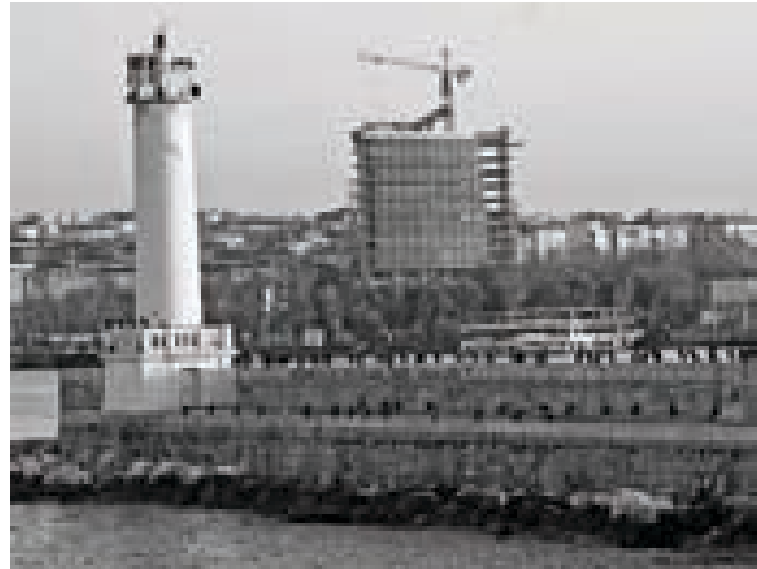
Kadıköylüler hayret ve dehşet içinde Moda sahilinde yükselen Corner Otel inşaatını izliyor. "İkinci Gökkafe" icraatını Büyükşehir'le CHP'li Kadıköy Belediyesi el ele yürütüyor.
