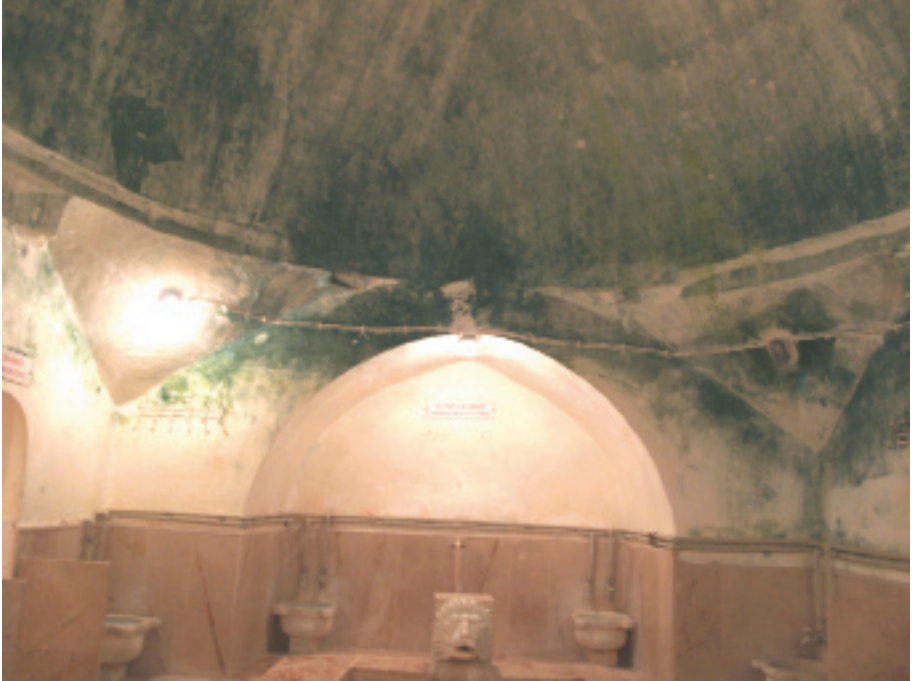
Alt Kat Sıcaklık Bölümü Doğu Duvar Eyvan Kuruluşu
