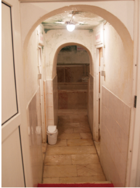
Yeni Alçık Hamamı Alt Kat Sıcaklığa Geçişi Sağlayan Koridorun İki Yanında Yer Alan Yıkanma Hücreleri
