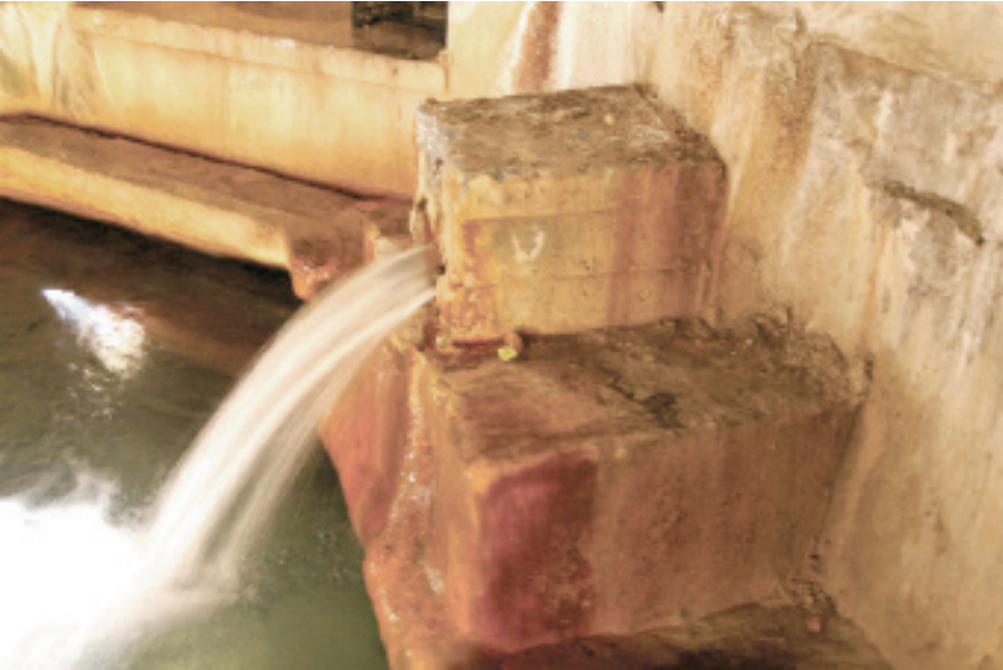
Hamamkarahisar Çardak Hamamı Su Oluđu ve Yıkanma Havuzu (A.Gerengi-2008)
