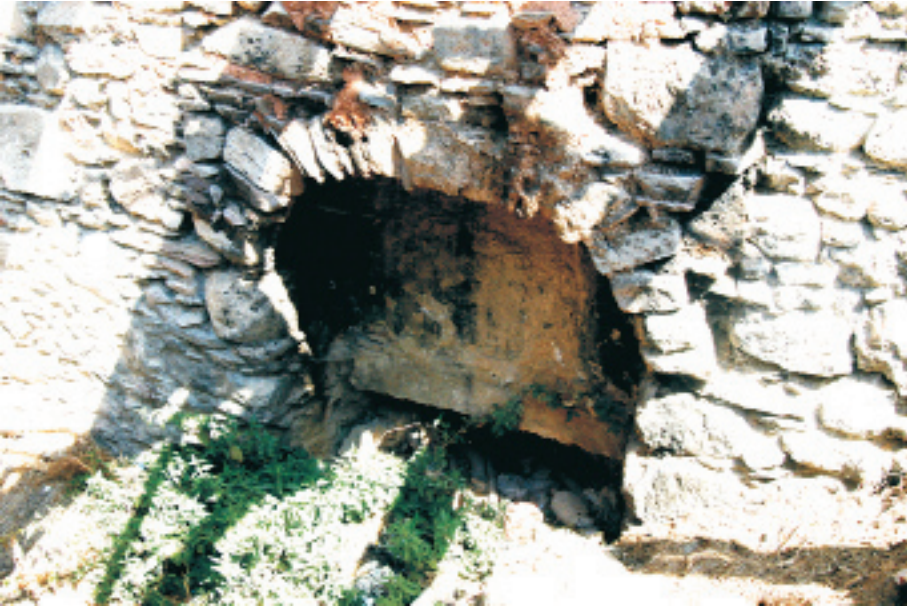
Seyitgazi Bardakçı Köyü Hamamı Küllhan Bölümü, Ocak (A.Gerengi-2008)
