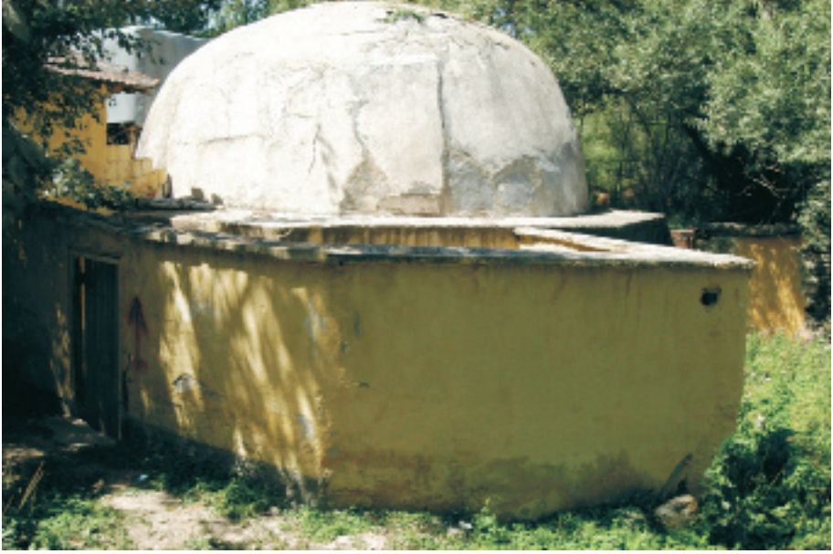
Hamamkarahisar Çardak Hamamı Erkekler Bölümü Genel Görünüő
