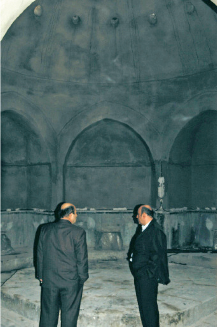
Seyitgazi Selçuk Hamamı Sıcaklık Bölümü (A.Gerengi-2007)
