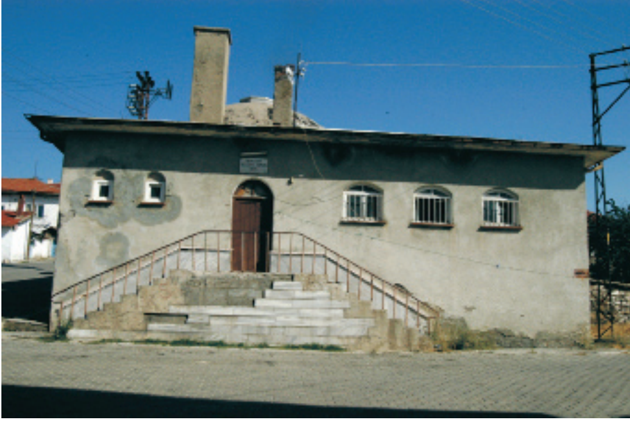
Mihaliççık Belediye Hamamı Güney Cephe (A.Gerengi-2008)
