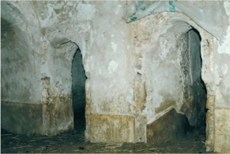
Seyitgazi Bardakçı Köyü Hamamı Halvet Hücrelerine Giriş Kapıları (A.Gerengi-2008)
