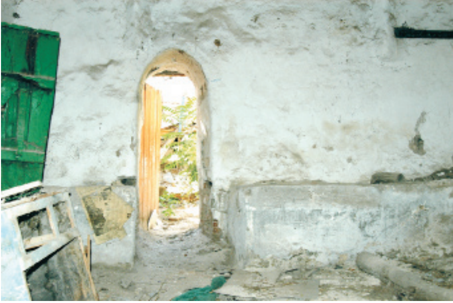
Sivrihisar Kumacık Hamamı Ilıklık Bölümü Giriş Kapısı (A.Gerengi-2008)
