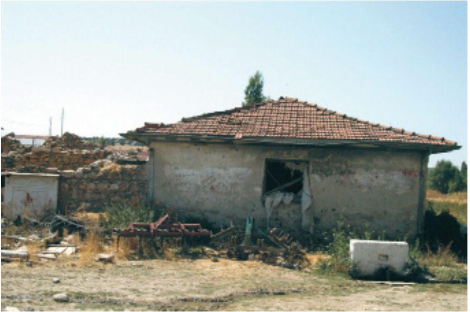
Seyitgazi Bardakçı Köyü Hamamı Kuzey Cephe (A.Gerengi-2008)
