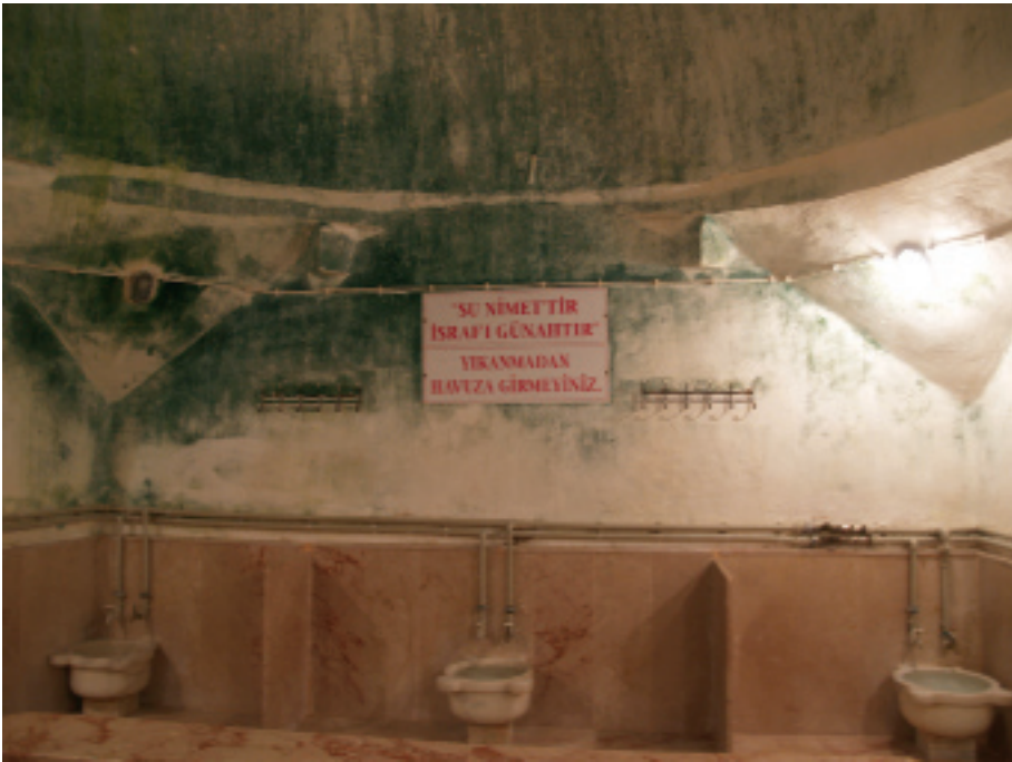
Yeni Alçık Hamamı Alt Kat Sıcaklık Bölümü Güney Duvar
