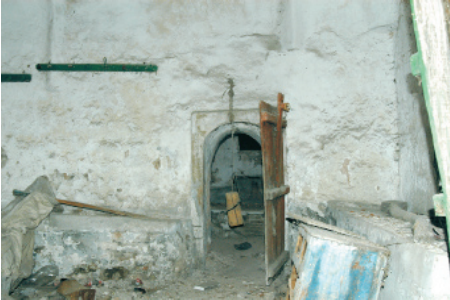
Sivrihisar Kumacık Hamamı Sıcaklık Bölümüne Giriş Kapısı (A.Gerengi-2008)
