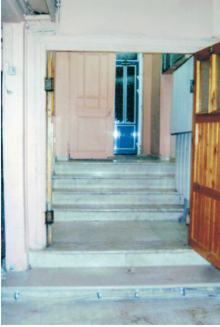
Erler Hamamı Kuzeybatıdaki giriş Bölümü
