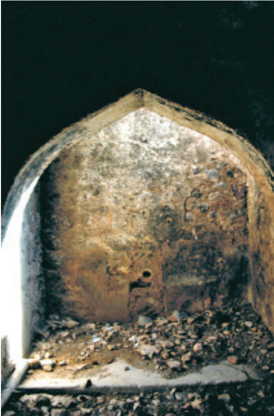
Seyitgazi, Aslanbey Köyü, Sücaaddin Hamamı Ilıklık Bölümü Kuzey Eyvanı (A.Gerengi-2008)
