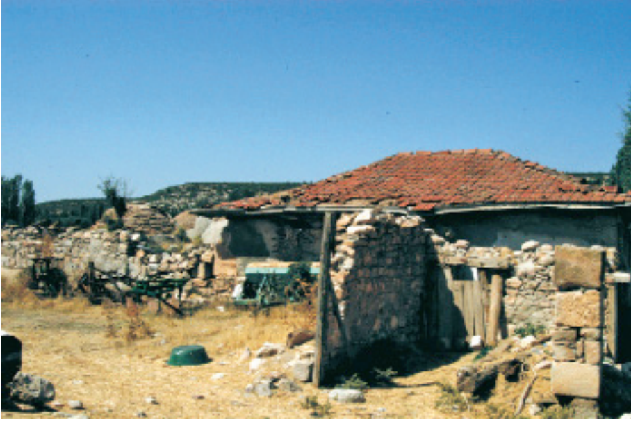
Seyitgazi Bardakçı Köyü Hamamı Doğu Cephe (A.Gerengi-2008)
