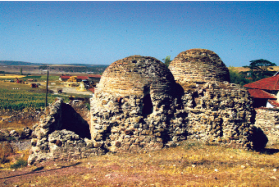
Seyitgazi, Aslanbey Köyü, Sücaaddin Hamamı Kuzey Cephe (A.Gerengi-2008)
