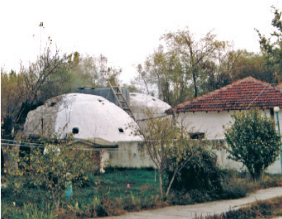
Hamamkarahisar Çardak Hamamı Güney Batıdan Genel Görünüş
