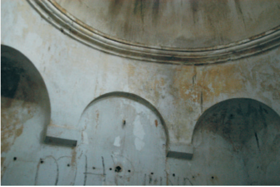
Mahmudiye Hara Hamamı Sıcaklık Bölümü Kubbe Geçişleri (A.Gerengi-2008)
