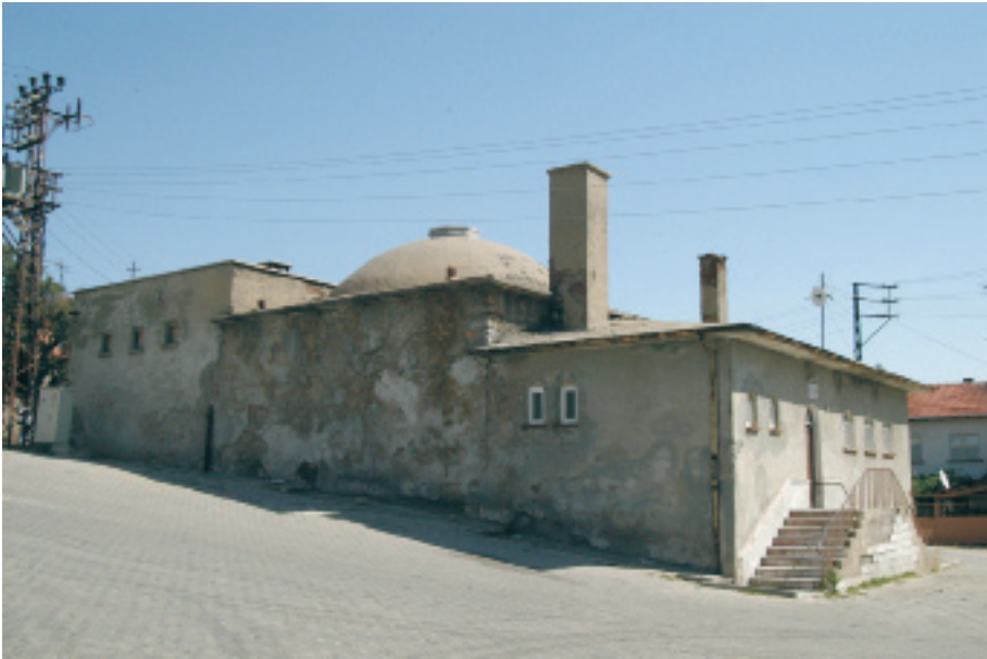
Mihaliççık Belediye Hamamı Batı Cephe (A.Gerengi-2008)
