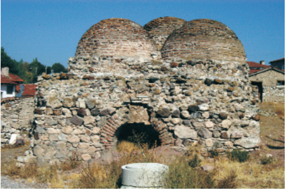
Seyitgazi, Aslanbey Köyü, Sücaaddin Hamamı Doğu Cephe (A.Gerengi-2008)
