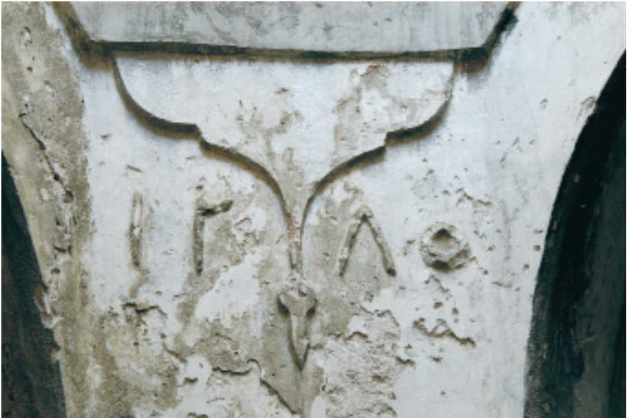
Sivrihisar Gavur Hamamı Sıcaklık Bölümü Kuzey Doğuda Bulunan H.1285 Yazılı Alçı Kaplama (A.Gerengi-2008)
