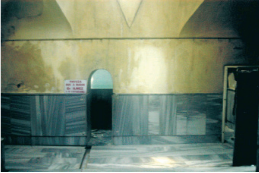
Sivrihisar Seyidiler Hamamı Sıcaklık Bölümü (A.Gerengi-2008)
