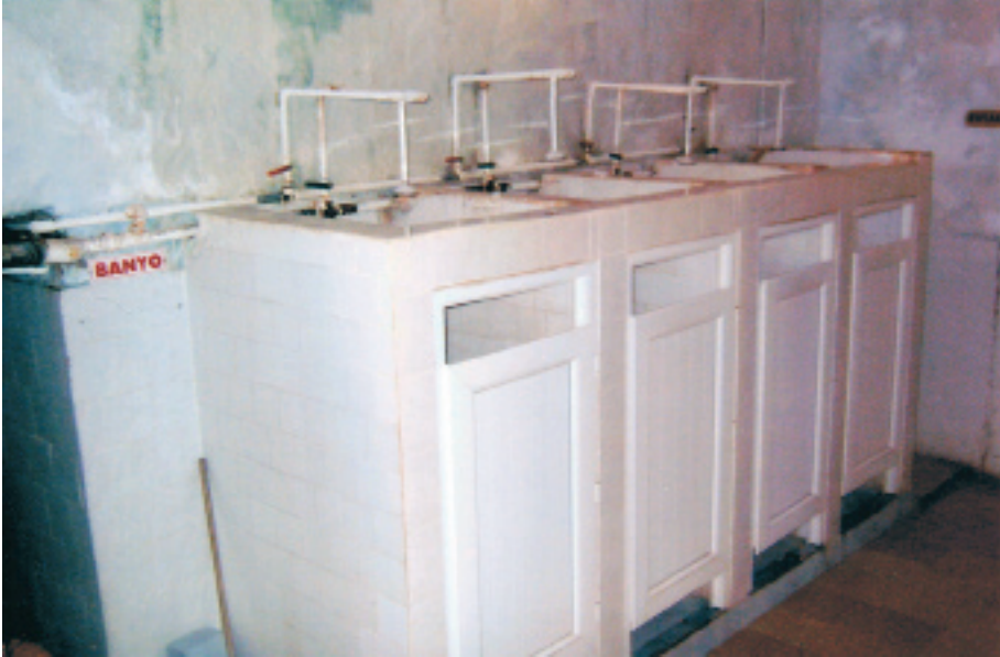
Erler Hamamı Ilıklık Bölümünde Yer Alan Duş Kabinleri
