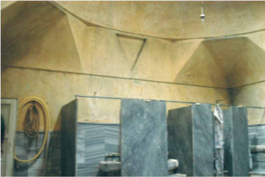
Sivrihisar Seyidiler Hamamı Sıcaklık Bölümü (A.Gerengi-2008)
