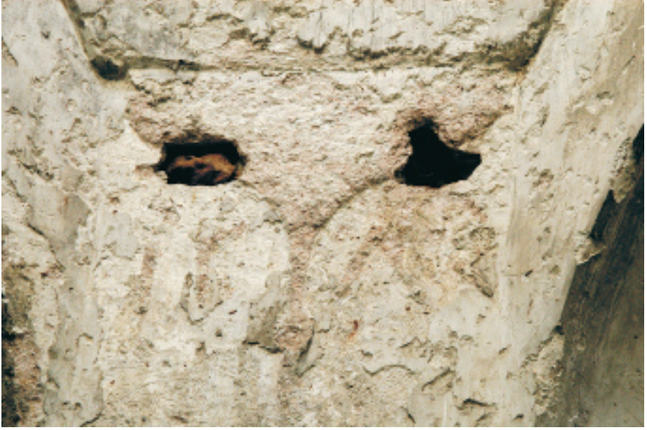
Sivrihisar Gavur Hamamı Sıcaklık Bölümü Güney Batıda Bulunan H.1284 Yazılı Alçı Kaplama (A.Gerengi-2008)
