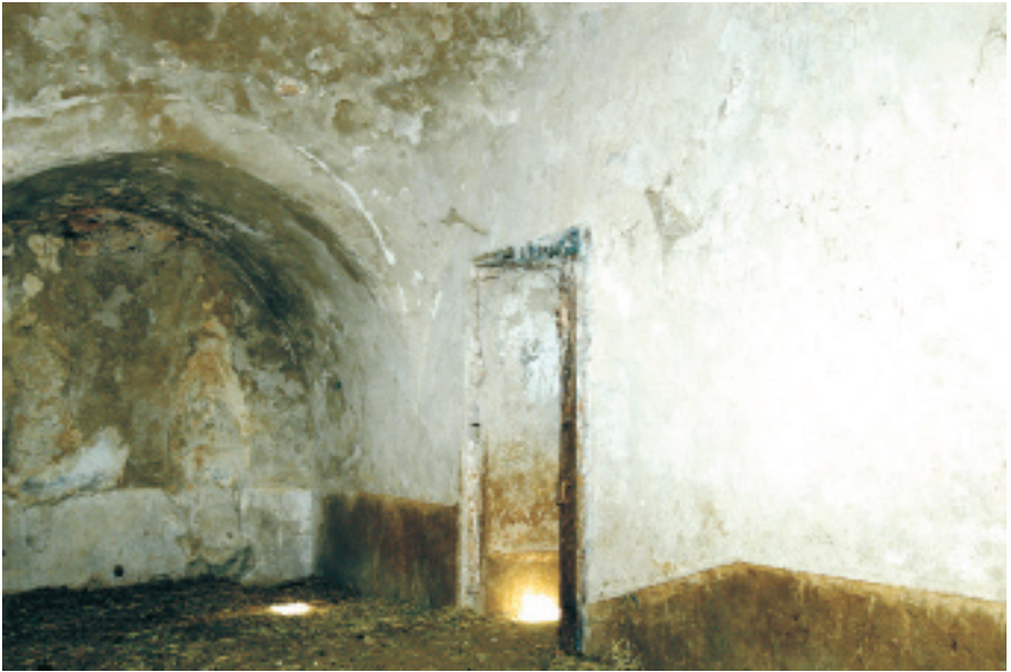
Seyitgazi Bardakçı Köyü Hamamı Sıcaklık Bölümü Giriş Kapısı (A.Gerengi-2008)
