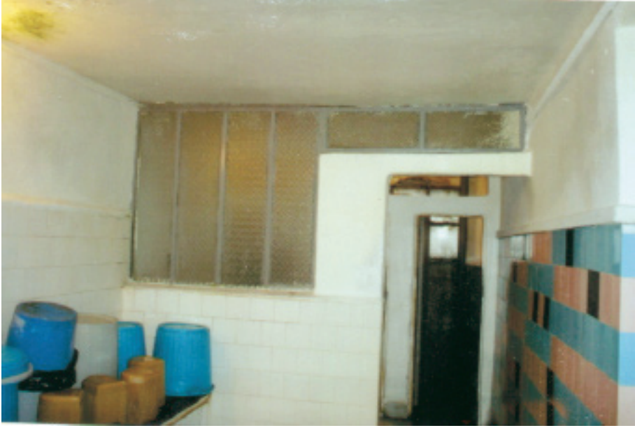
Işık Hamamı Sıcaklık Bölümü Tuvaletlerin Bulunduğu Bölüm
