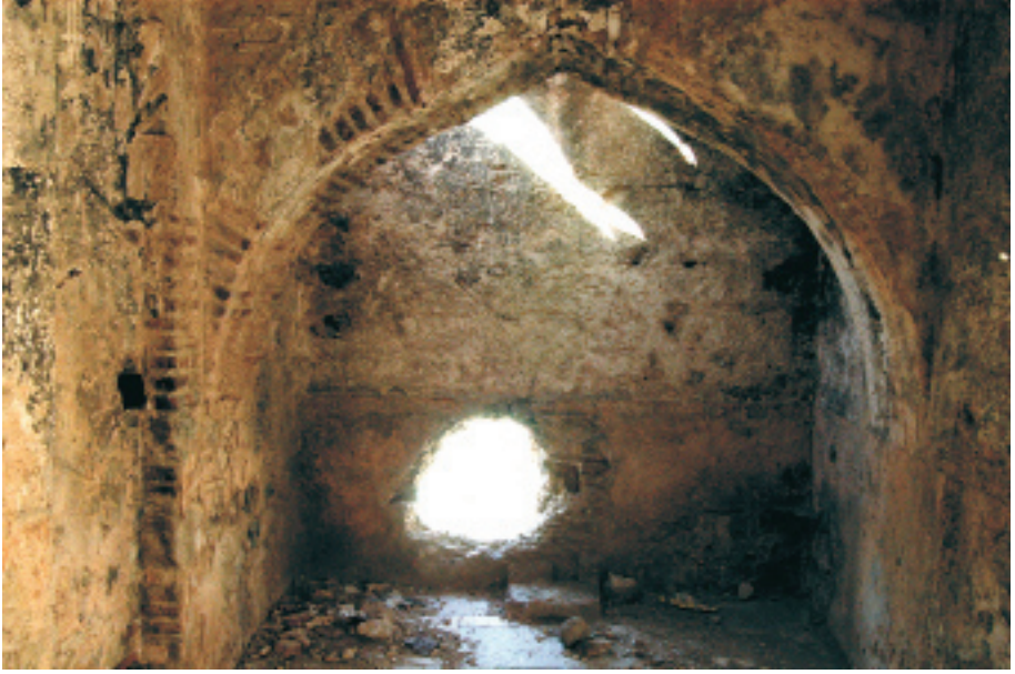
Seyitgazi, Aslanbey Köyü, Sücaaddin Hamamı Ilıklık Bölümü Güney Eyvanı (A.Gerengi-2008)
