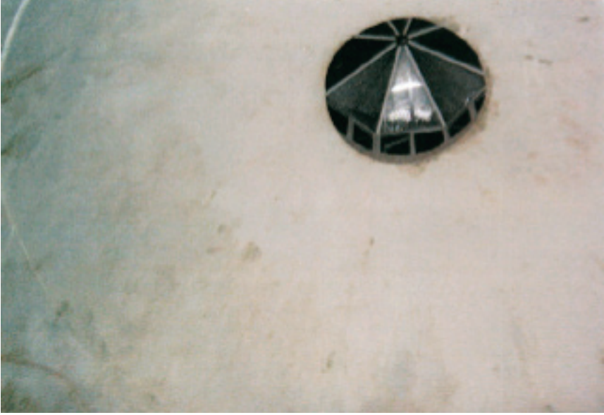
Erler Hamamı Ilıklık Bölümü Kubbesi
