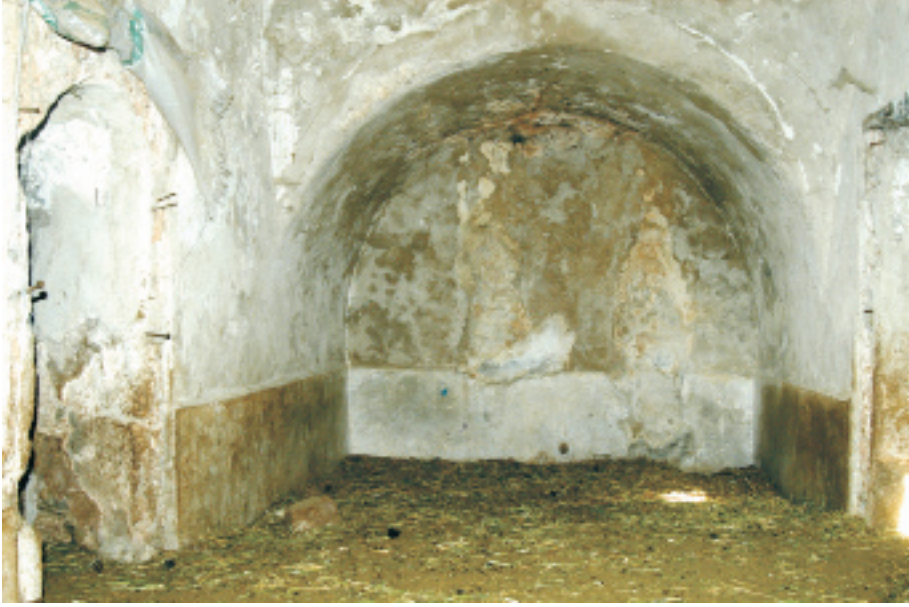
Seyitgazi Bardakçı Köyü Hamamı Sıcaklık Bölümü, Batı Eyvanı (A.Gerengi-2008)
