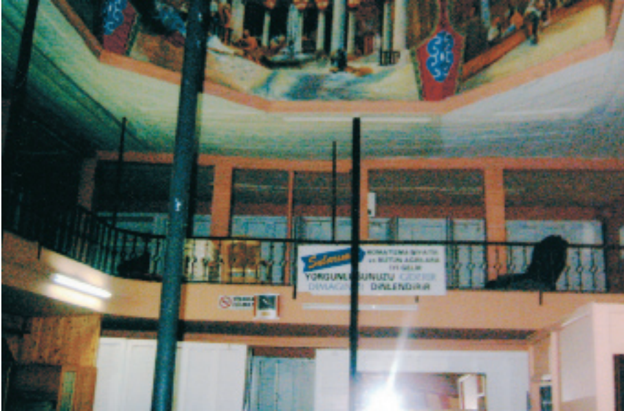
Erler Hamamı Soyunmalık Bölümü Galerî Katı
