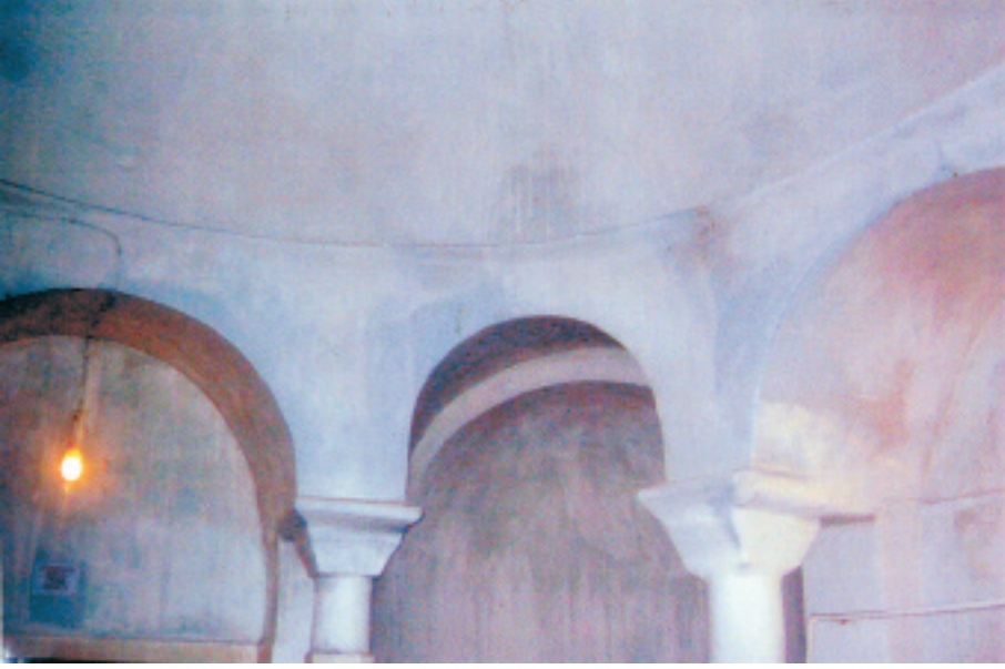
Erler Hamamı Sıcaklık Bölümü Kubbe
