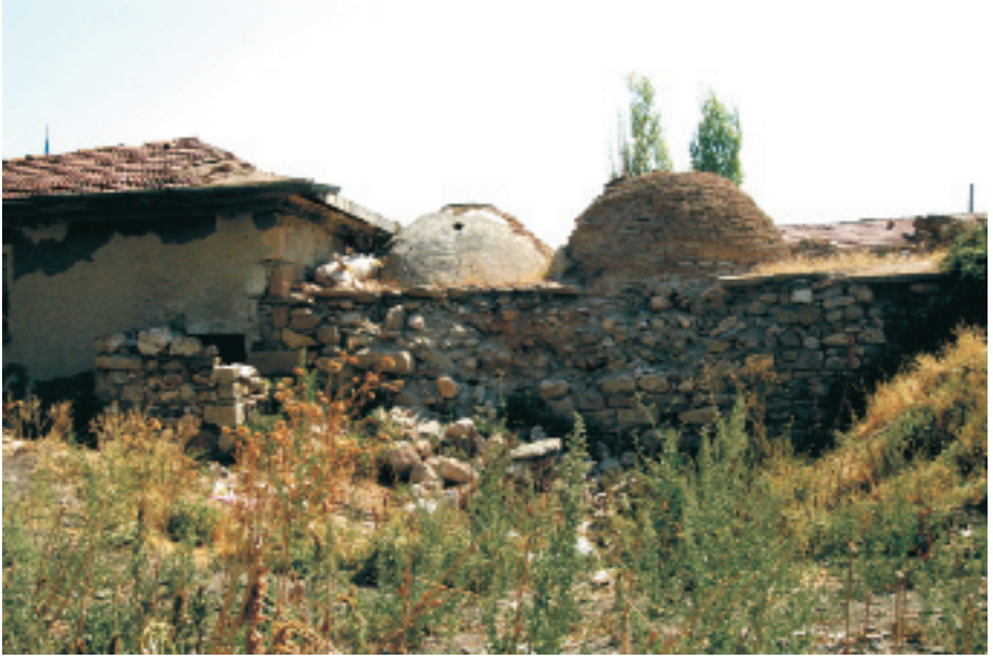
Seyitgazi Bardakçı Köyü Hamamı Batı Cephe (A.Gerengi-2008)
