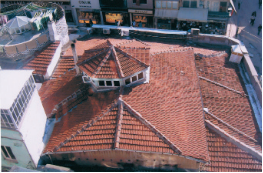
Erler Hamamı Soyunmalık Bölümü Örtü Sistemi
