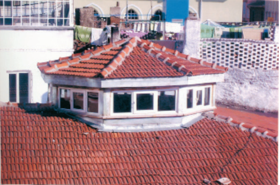
Erler Hamamı Soyunmalık Bölümünün Aydınlık Feneri
