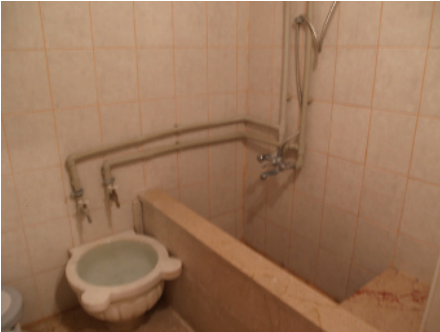
Yeni Alçık Hamamı Alt Kat Sıcaklığa Geçişi Sağlayan Koridorun İki Yanında Yer Alan Yıkanma Hücrelerinden Genel Görünüm
