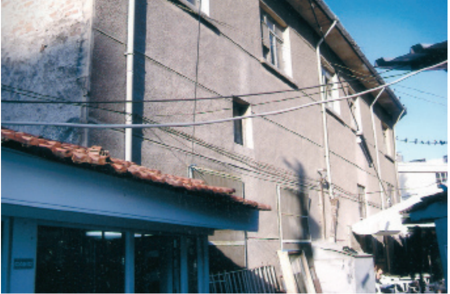
Işık Hamamı Batı Cephe
