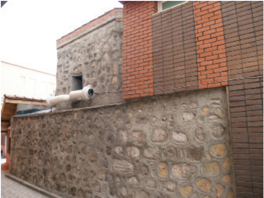
Yeni Alçık Hamamı Batı Cephe
