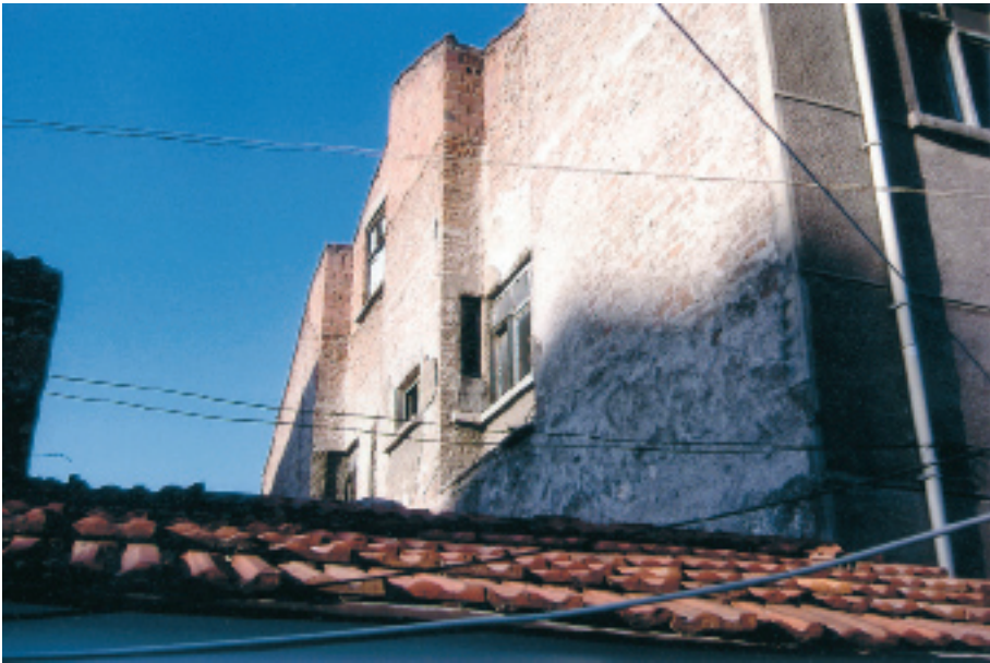
Işık Hamamı Kuzey Cephe
