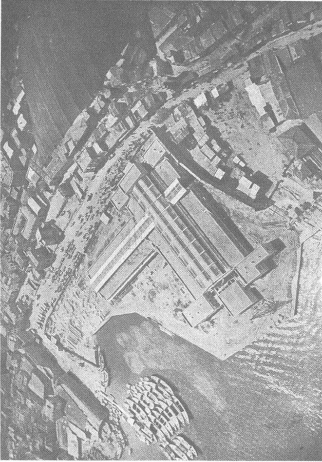
Resim 5: Belediye Sebze Hali, inşaat sırasında. ("İstanbul Sebze ve Meyve Hali", Arkitekt, 1935:192) Alanın her iki yanındaki duvarlar Odunkapanı-Keresteciler Çarşısı'nın yangın duvarlarıdır. İnşaat tamamlandıktan sonra yıkılmıştır.
