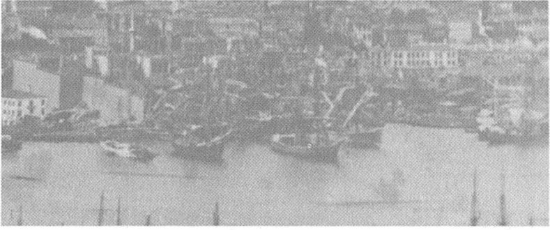
Odunkapı - Yangın Duvarı
