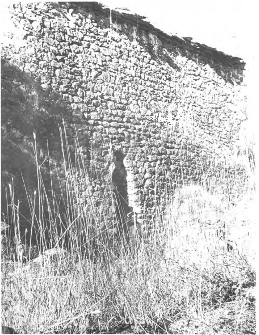
Bedgaruk / Derareş (Karakilise) Nesturi Temel Kilisesi giriş kapısı (Kapı yarım kemerli)
