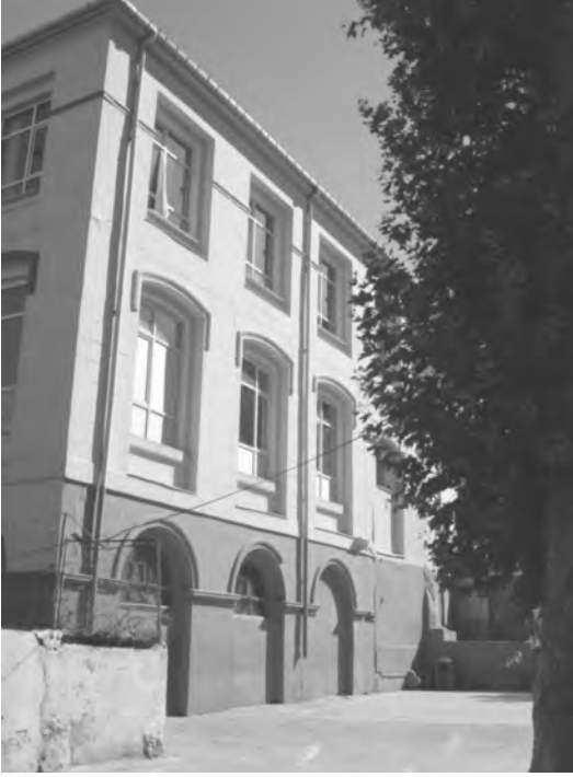
Resim 17: Kuzey cephede kapatılan pencereler
