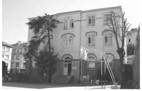
Resim 9: Kabataş Ticaret Meslek Lisesi doğu (giriş) cephesi
