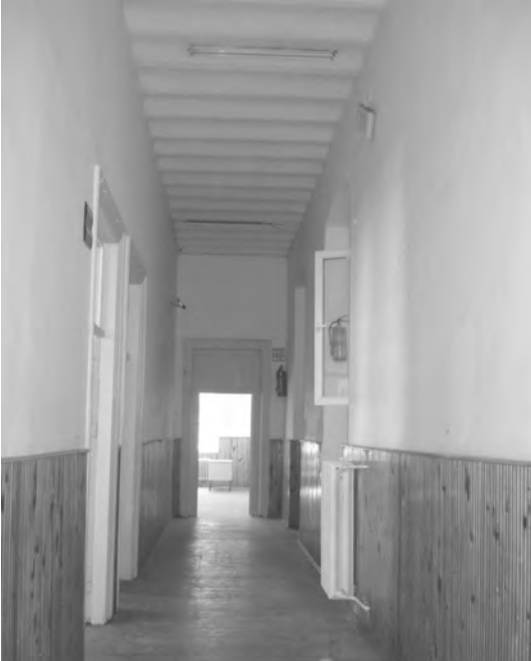
Resim 13: Koridor tavanında volta döşeme
