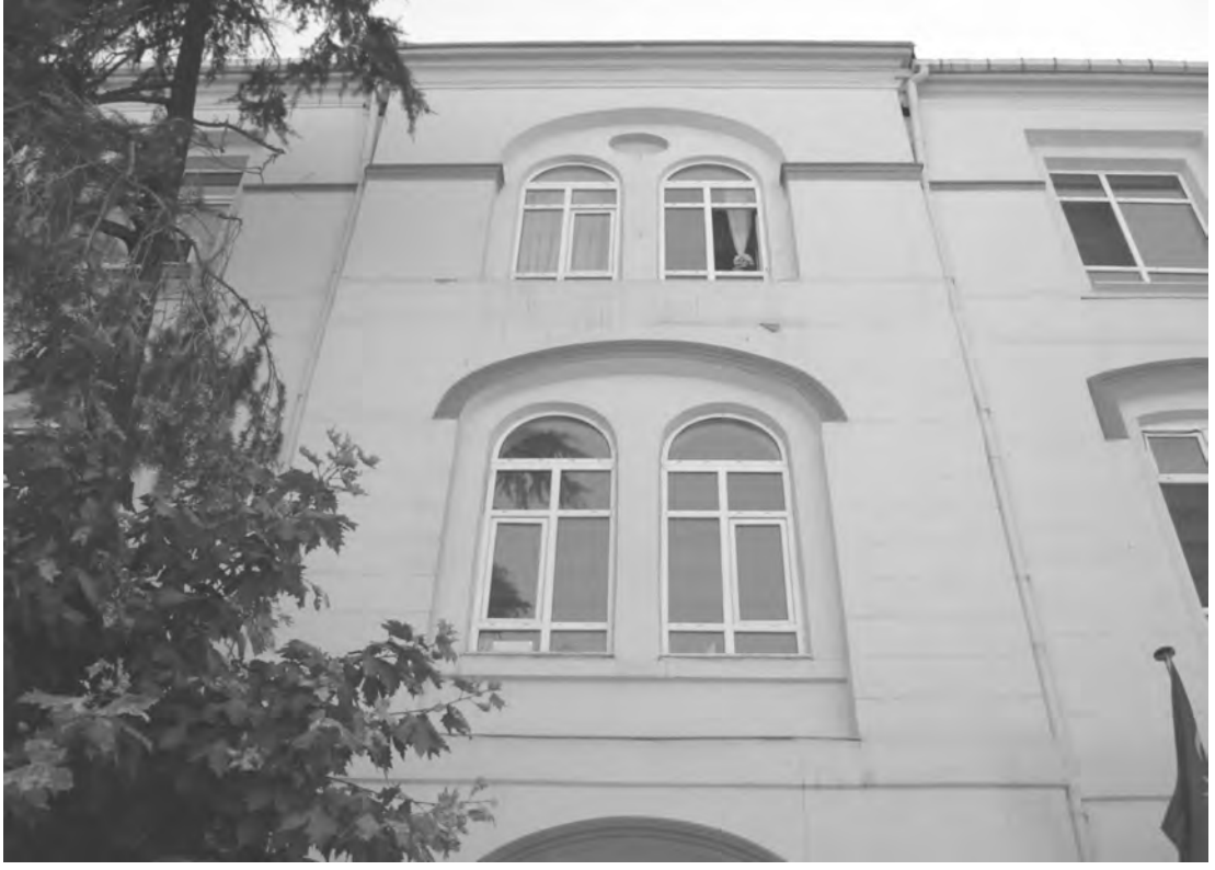
Resim 16: Giriş cephesinde dışa taşan bölüm
