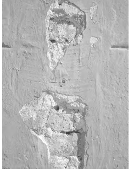
Resim 18: Duvarda örgü malzemesi ve tekniği
