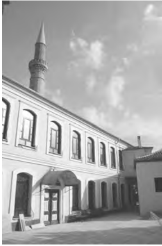
Resim 1: Yeni Cami kuzey cephesi görünüşü
