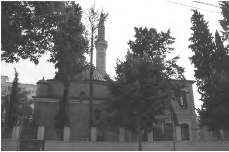
Resim 2: Yeni Cami doğu cephesi görünüşü
