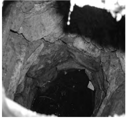
Res. 6: Altı Poğça camii yanında yer alan su kuyusu.
