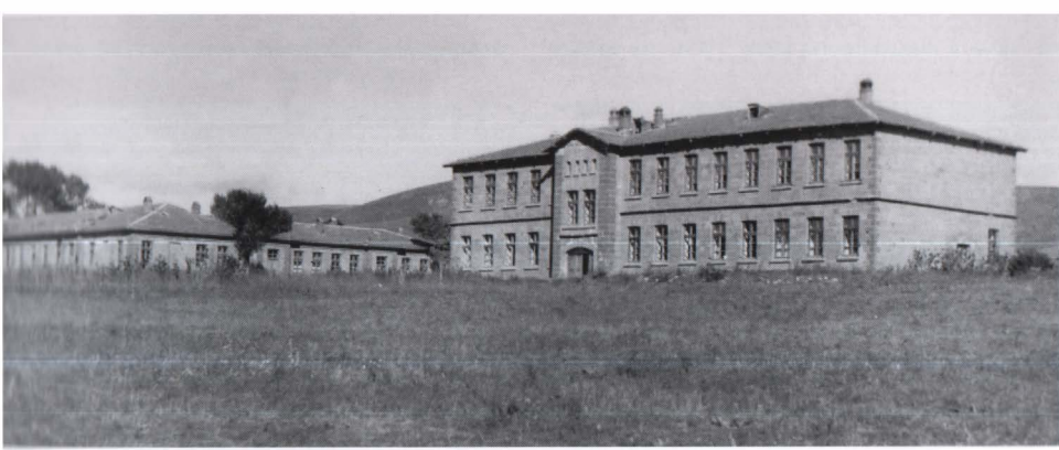
Şekil 3: Cılavuz Köy Enstitüsü binaları (1943). Firdevs Gümüşoğlu Arşivi.
