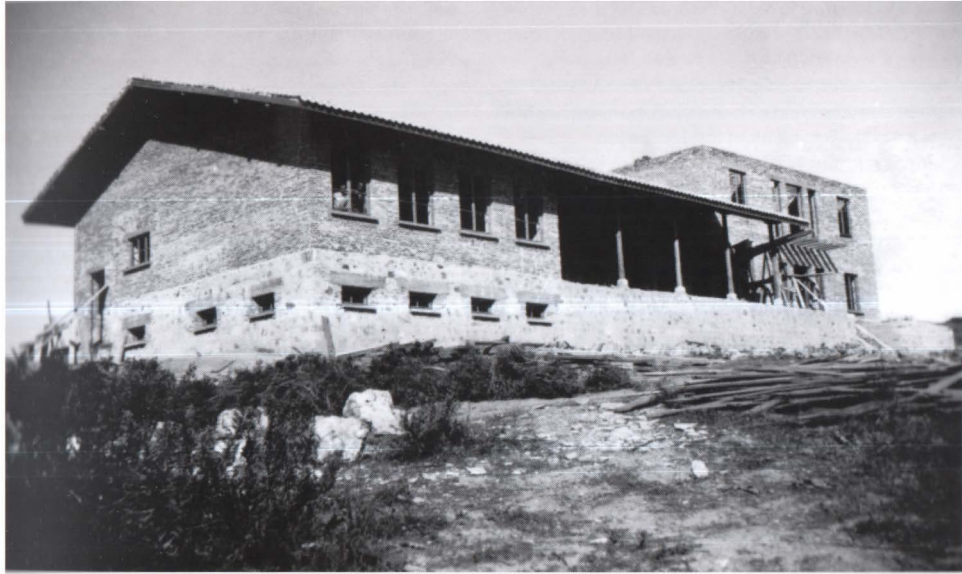
Aksu Köy Enstitüsü'nün inşa halindeki büyük yapılarından biri. İ.H. Tonguç Belgesi
