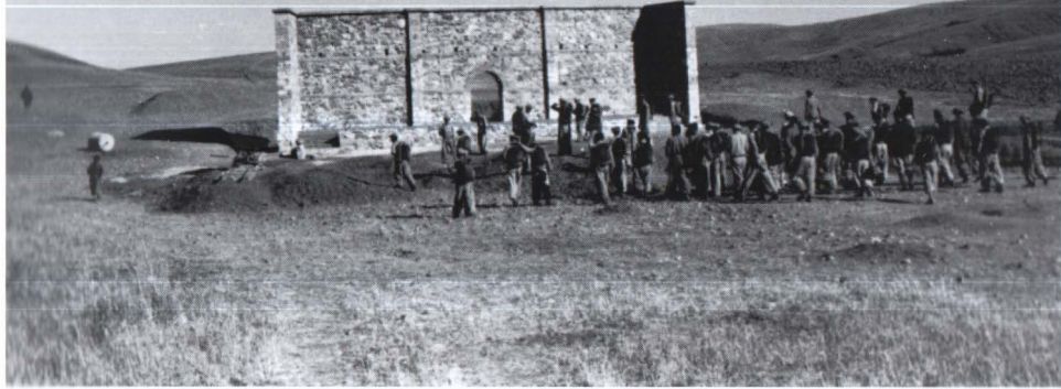
Hasanoglan Köy Enstitüsü'nün açık hava tiyatrosunun inşasında çalışan öğrenciler. İ.H. Tonguç Arşivi Students working at the construction of the amphitheater at Hasanoglan Village Institute. İ.H. Tonguç Archives
