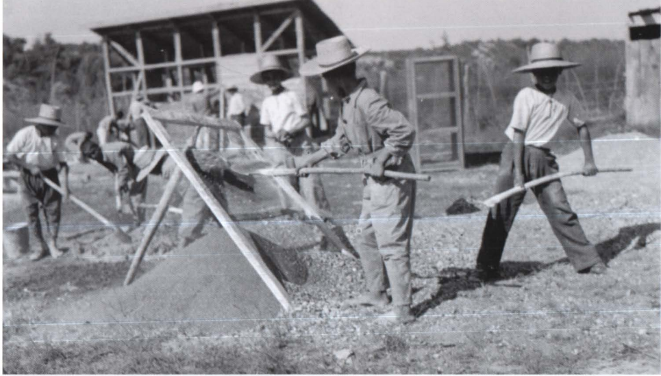
Harç yapımı için kum eleyen Aksu Köy Enstitüsü öğrencileri. İ.H. Tonguç Belgeliği Aksu Village Institute students sifting sand for making mortar. İ.H. Tonguç Archives
