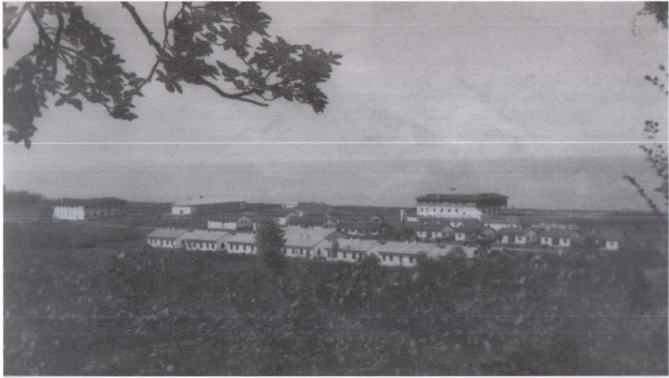
Şekil 1: Trabzon Beşikdüzü Köy Enstitüsü'nün Çamlıközü'ndeki binaları (deniz kenarında ve güneydeki L binalar, dershaneler, işlikler). Figure 1: Trabzon Beşikdüzü Village Institute's buildings in Çamlıközü (L-shaped buildings, classrooms, and workshops on the seashore and in the south). Rep. Karadeniz Archives.
