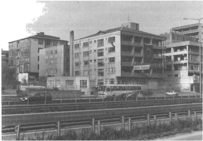
Şirinevler’de küllerinden doğmaya çalışan Kültür Koleji’nin ilk binası.
