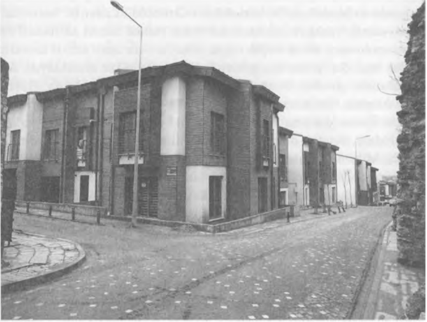
Kara surlarının hemen iç kısmında yer alan yeni Sulukule evleri
