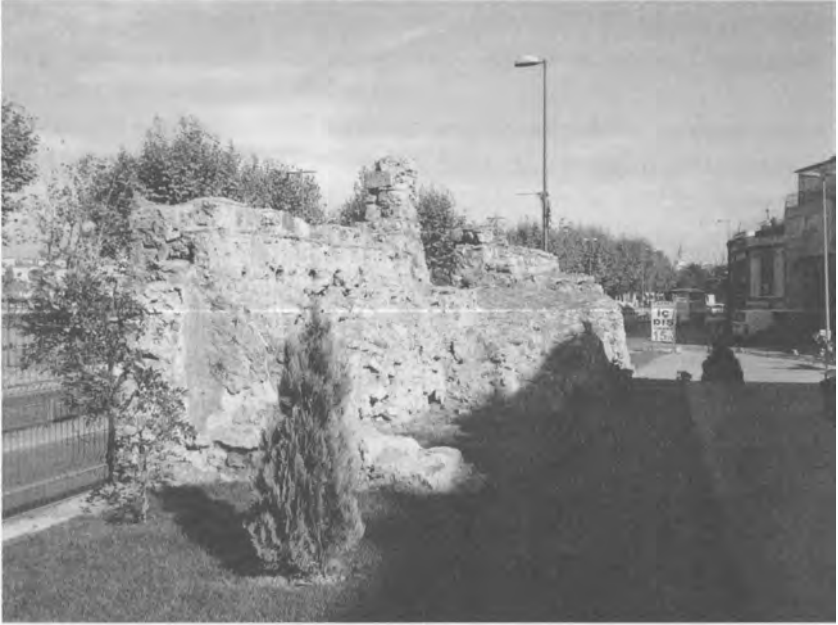
Ayvansaray-Fener hattında Haliç Surlarından bir görüntü
