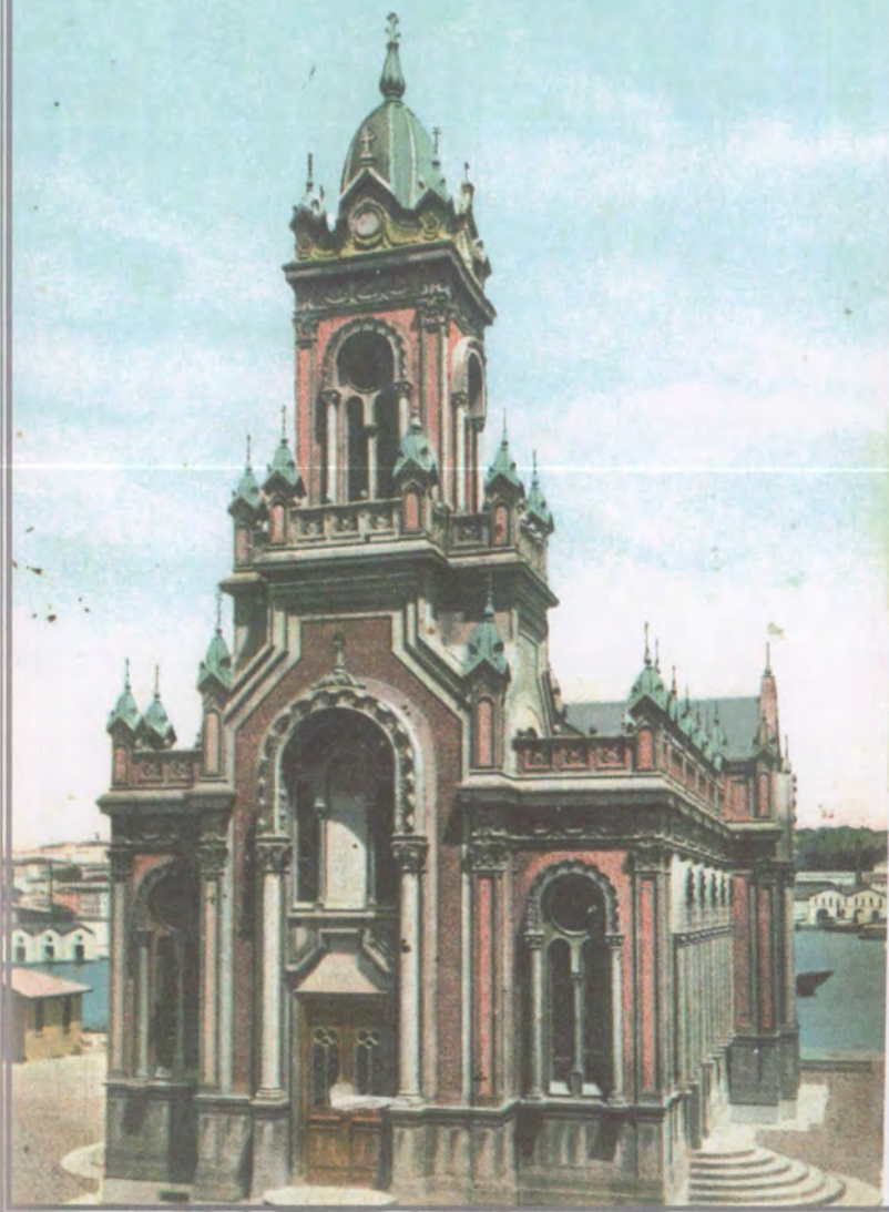
Tamamen demirden imal edilen Bulgar Sveti Stefan Kilisesi'nin kara tarafından görünüşü
