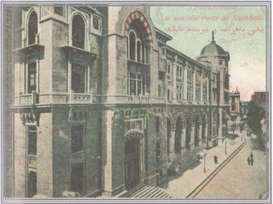
'irkeci'deki Büyük Postane binası yaklaşık 100 yıllık bir yapıdır ve Vedat Tek'in eseridir.
