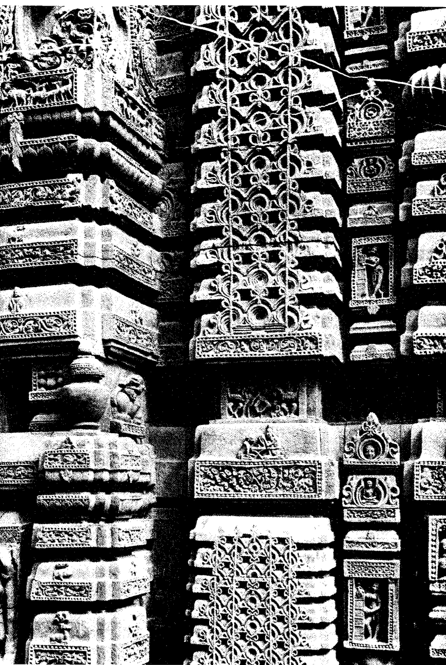
20) Muktesvara Tapinaḡi, Sikhara, ayrıntı.
