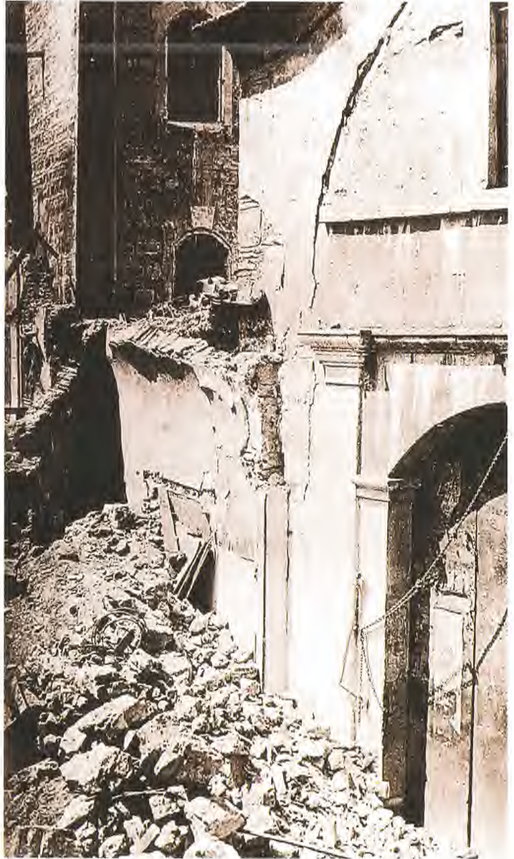
Kapalıçarşı'nın Nuruosmaniye Kafesi'nin hemen yanındaki kebapçı dükkanının 1894 depremi sonucu hali.
