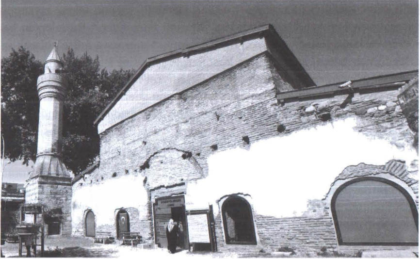
Şekil 3. Ayasofya’nın restorasyon sonrasında giriş cephesi ve minaresi (Yazar, 2017)
