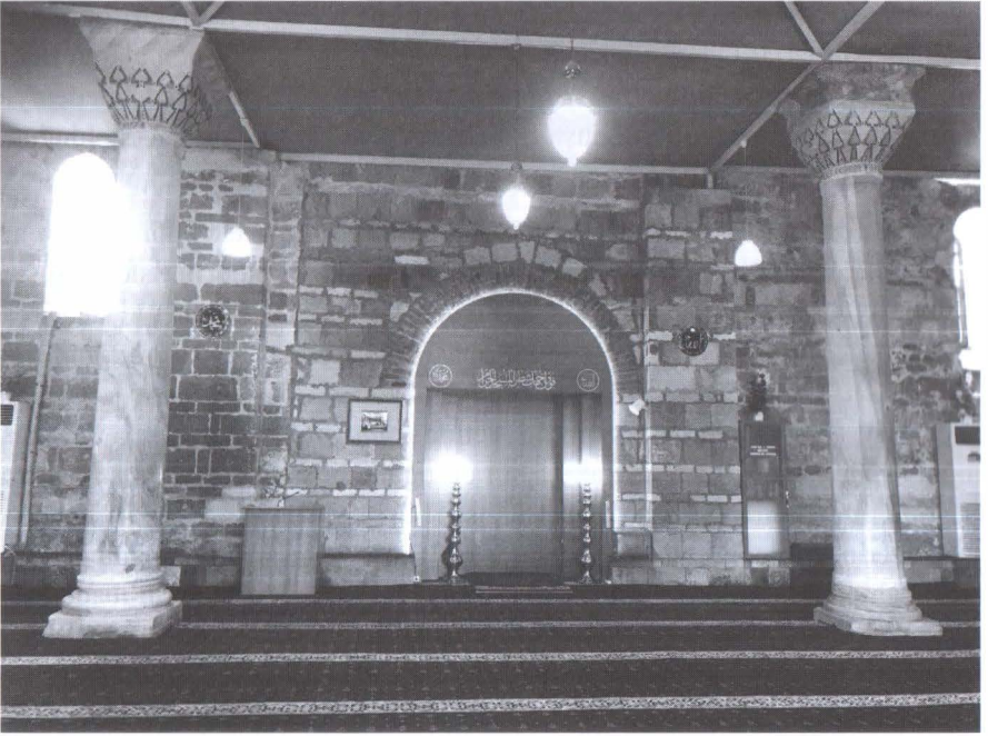
Şekil 8. Trabzon Ayasofya'sının naosunun üst örtüsünü geçici olarak kapatan kontrplak ve ahşap mihrap (Yazar, 2017)
