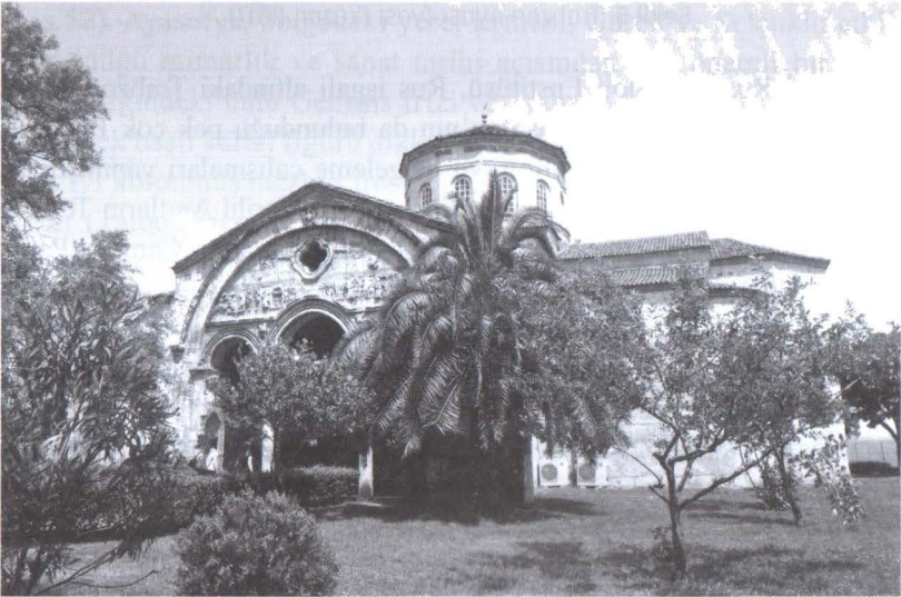
Şekil 6. Trabzon Ayasofyası’nın güney cephesi ve portiğin üzerindeki Genesis frizi (Yazar, 2017)
