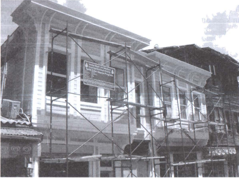
Şekil 7. 2008 tarihli KUDEB uygulamasında Haydar Caddesi üzerinde cephesi onarılan bir yapı (Fotoğraf: İstanbul KUDEB Arşivi).
