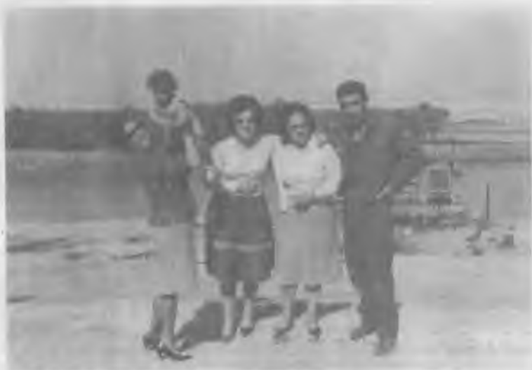
Huseyma, Dilnaz, Rewşen Bedirxan, Sînemxan û Nûrî (bîrayê Selah Saadalla), Pumping Station, K3 Iraq, 1962
